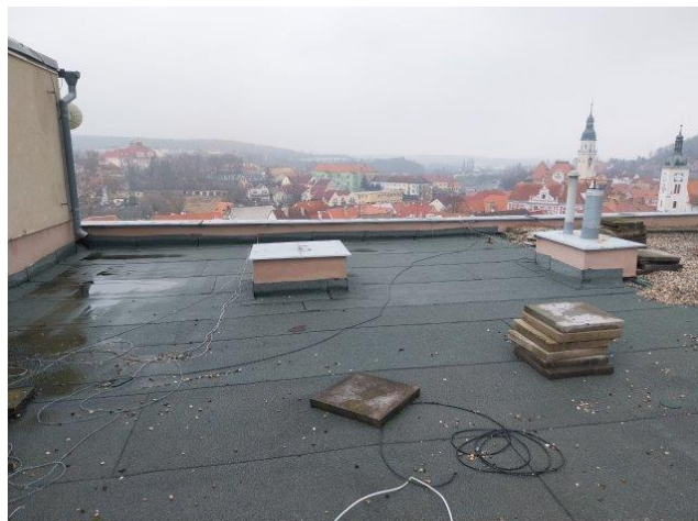
Pohled na plochu střechy bez stabilizační a ochranné vrstvy - fotografie z místního šetření provedeného dne 26. 02. 2025
