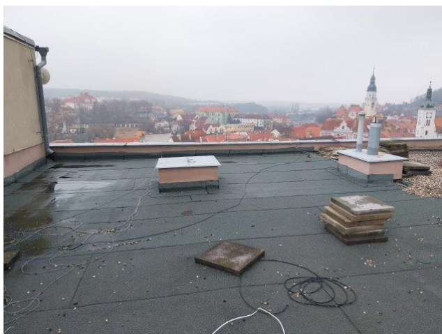
foto /4/ Pohled na plochu střechy bez stabilizační a ochranné vrstvy - fotografie z místního šetření provedeného dne 26. 02. 2025
