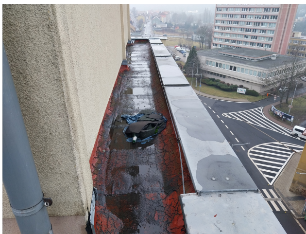
foto /1/ Pohled na řešení hydroizolace za střešní nástavbou - fotografie z místního šetření [27] provedeného dne 26. 02. 2025
