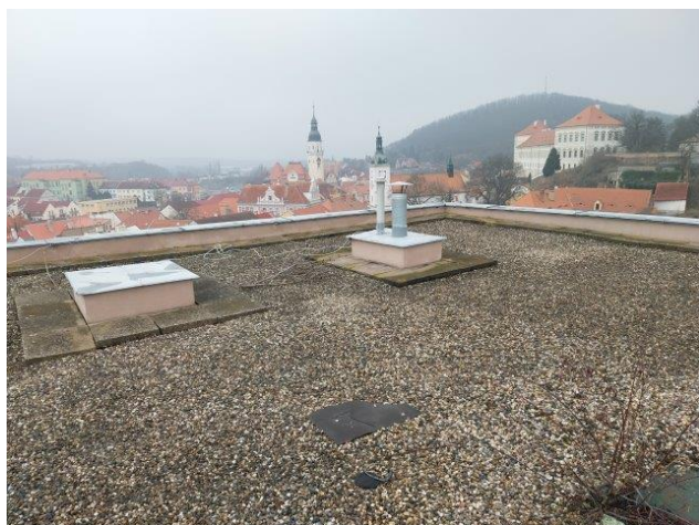
foto /3/ Pohled na plochu střechy se stabilizační a ochrannou vrstvou - fotografie z místního šetření provedeného dne 26. 02. 2025
