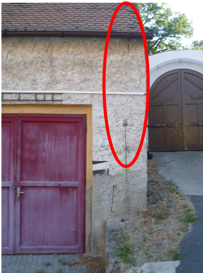
Chybějící hromosvod
