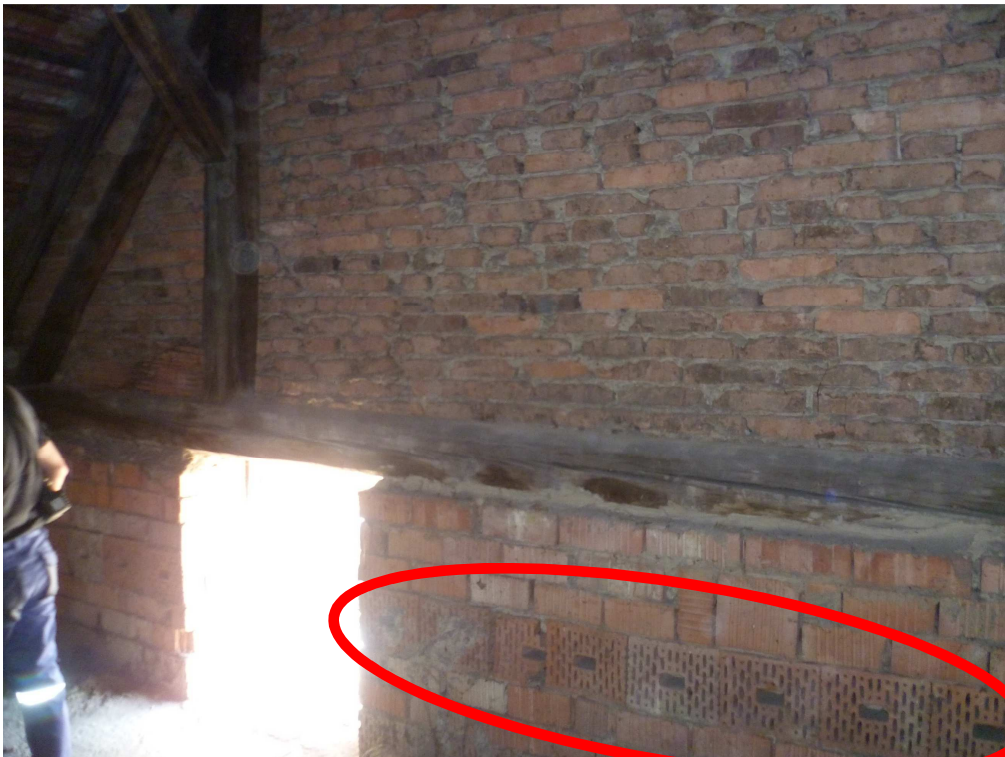
Chybná orientace děrovaných cihel.
