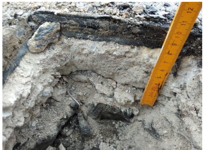
foto /7/ Odměrování vrstvy betonové mazaniny
