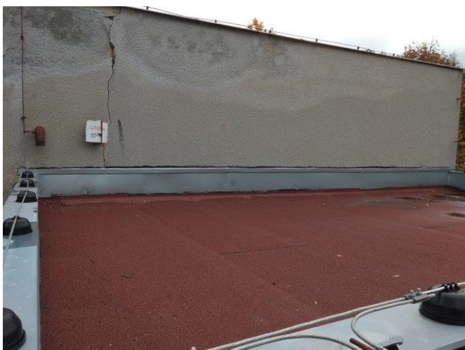
foto /22/ Pohled na opravenou střechu trafo stanice
