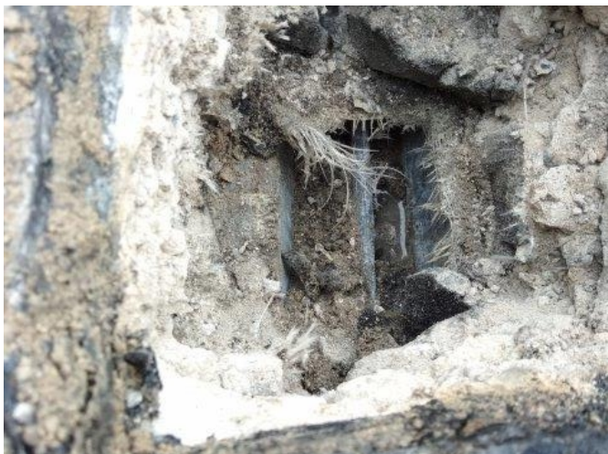
foto /8/ Pohled do provedené sondy
