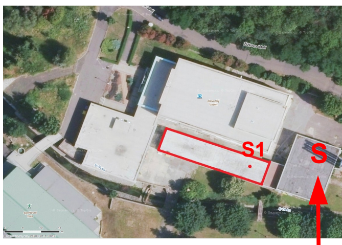
obr. /1/ Letecký pohled (zdroj: https://mapy.cz/ ) s vyznačením předmětné střechy ( červené ohrazení) a provedené sondy S1
