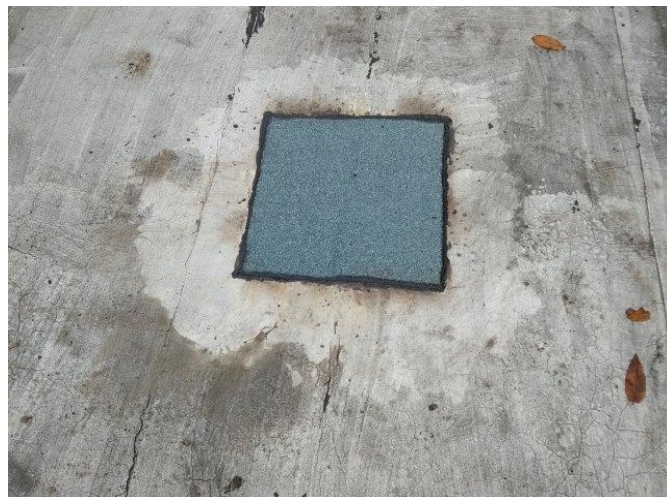
foto /9/ Pohled na zapravenou sondu
