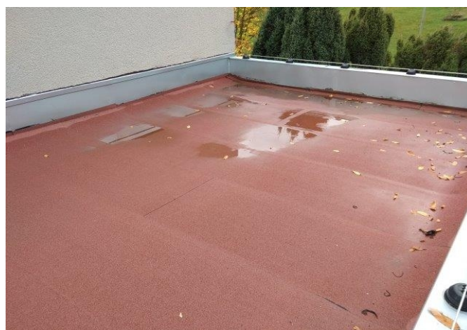
foto /3/ Pohled na opravenou střechu trafo stanice
