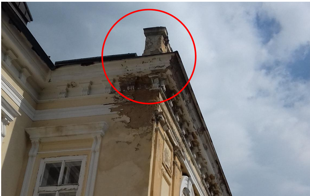
Degradace zdiva s označením místa zatékání srážkové vody do objektu
