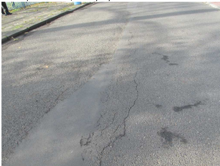
37) Detail vozovky na mostě v podélné ose / trhliny krytu
