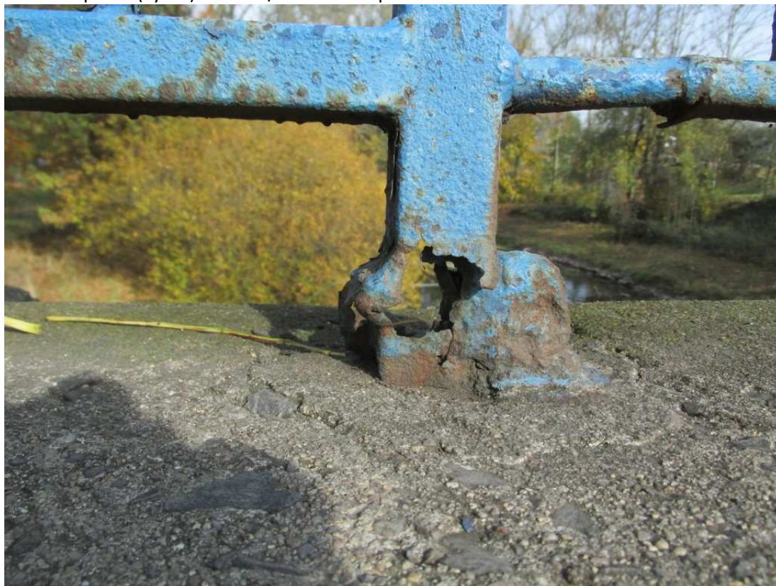
19) Zábradlí vpravo (výtok) – detail / koroze sloupků v ukotvení
