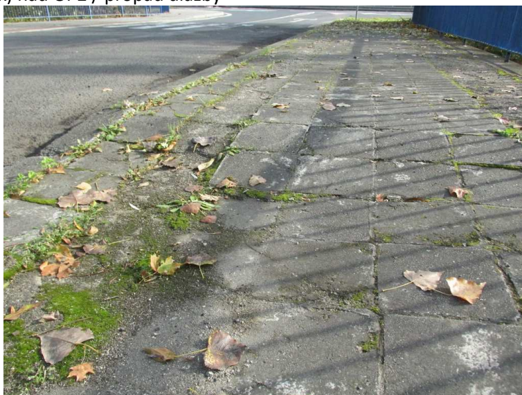
41) Chodník vlevo (vtok) nad OP2 / propad dlažby
