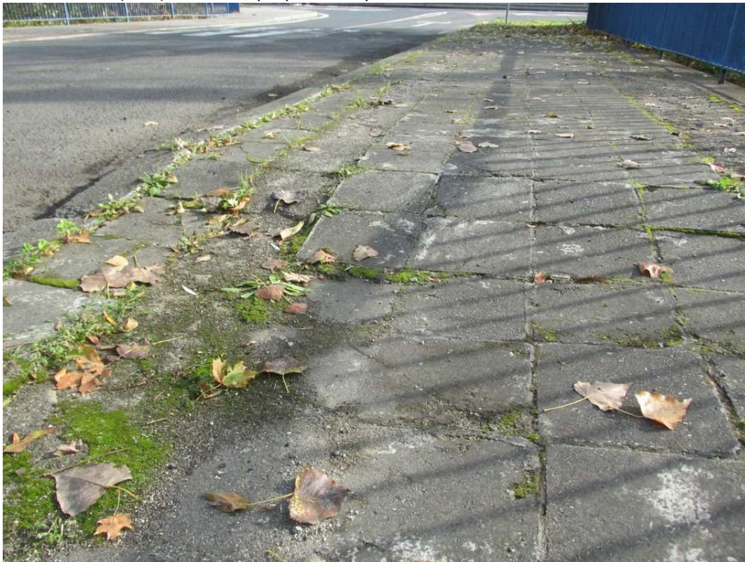
13) Chodník vlevo (vtok) nad OP2 / propad dlažby
