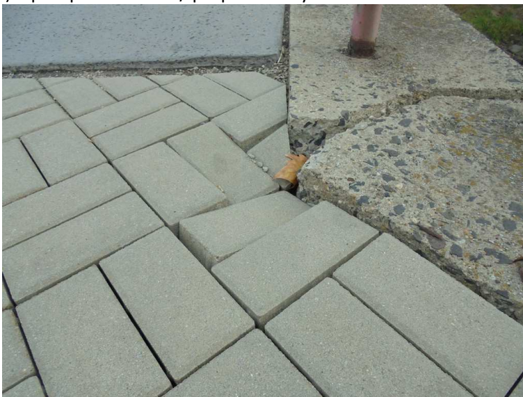
44) Chodník vlevo (vtok) – předpolí nad OP2 / propad dlažby
