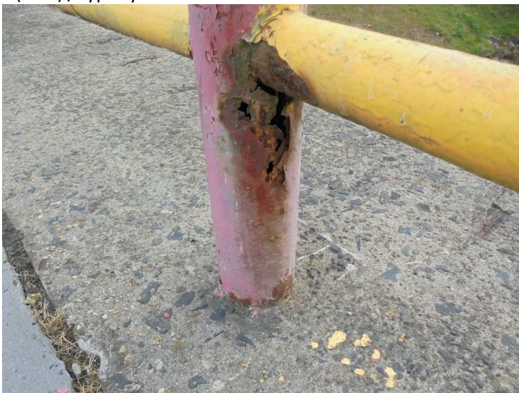
45) Vnější zábradlí vlevo (vtok) / typický detail hloubkové koroze
