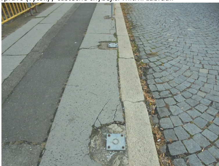
54) Chodník a zábradlí vpravo (výtok) / částečné chybějící vnitřní zábradlí – nerovnosti po původním ukotvení zábradelních sloupků
