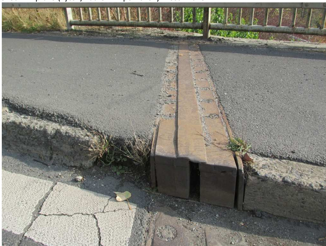
14) Chodník vpravo (výtok) nad OP2 – povrchový mostní závěr
