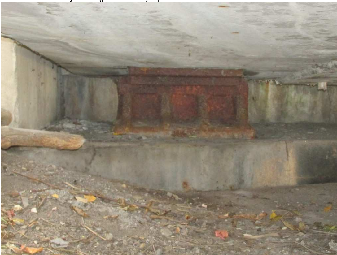
32) NK – uložení na krajní OP1 (pravobřežní) – pevná ložiska
