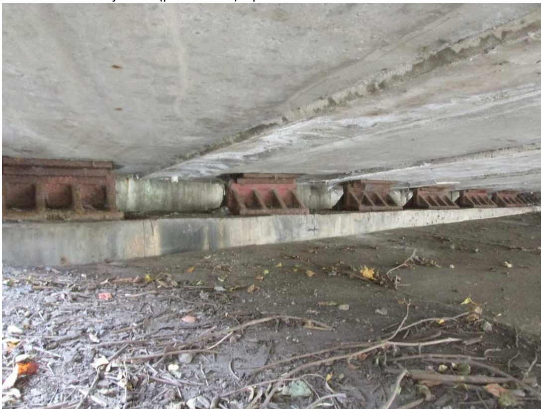
31) NK – uložení na krajní OP1 (pravobřežní) – pevná ložiska
