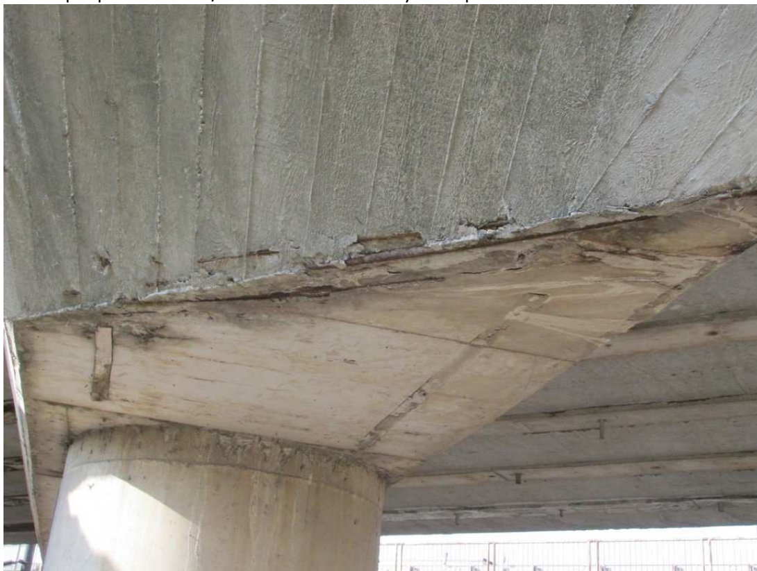
21) Mezilehlá podpěra P2 zleva / stativo s obnaženou výztuž v podhledu
