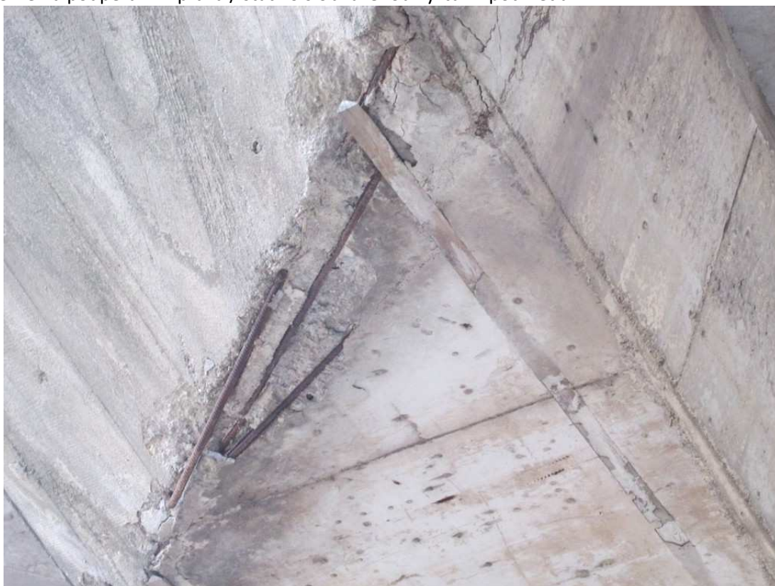
20) Mezilehlá podpěra P2 zprava / stativo s obnaženou výztuž v podhledu
