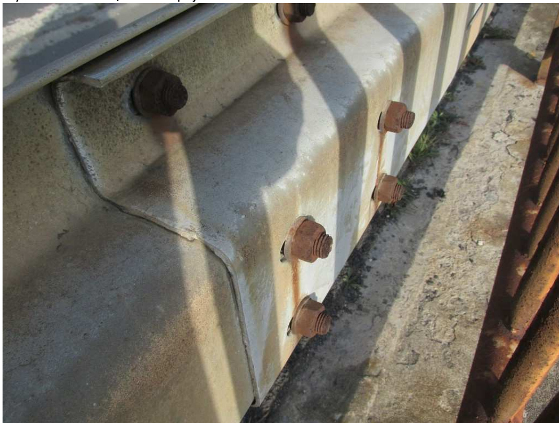
25) Typický detail svodidel / koroze spojovacího materiálu
