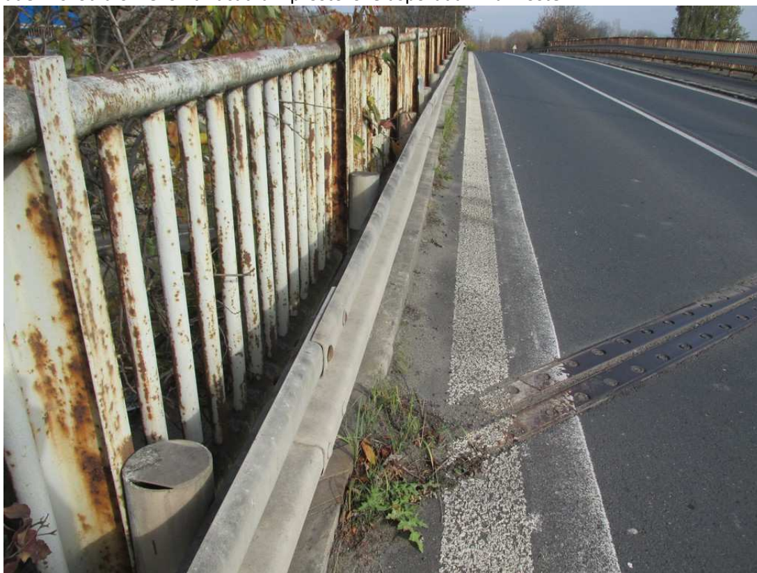
18) Zábradelní svodidlo vlevo na začátku – prostorové uspořádání na mostě
