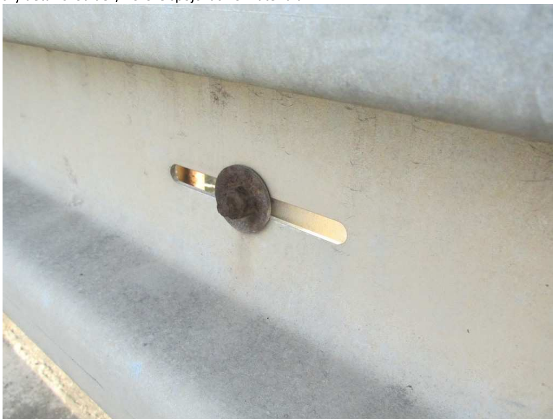
26) Typický detail svodidel / koroze spojovacího materiálu
