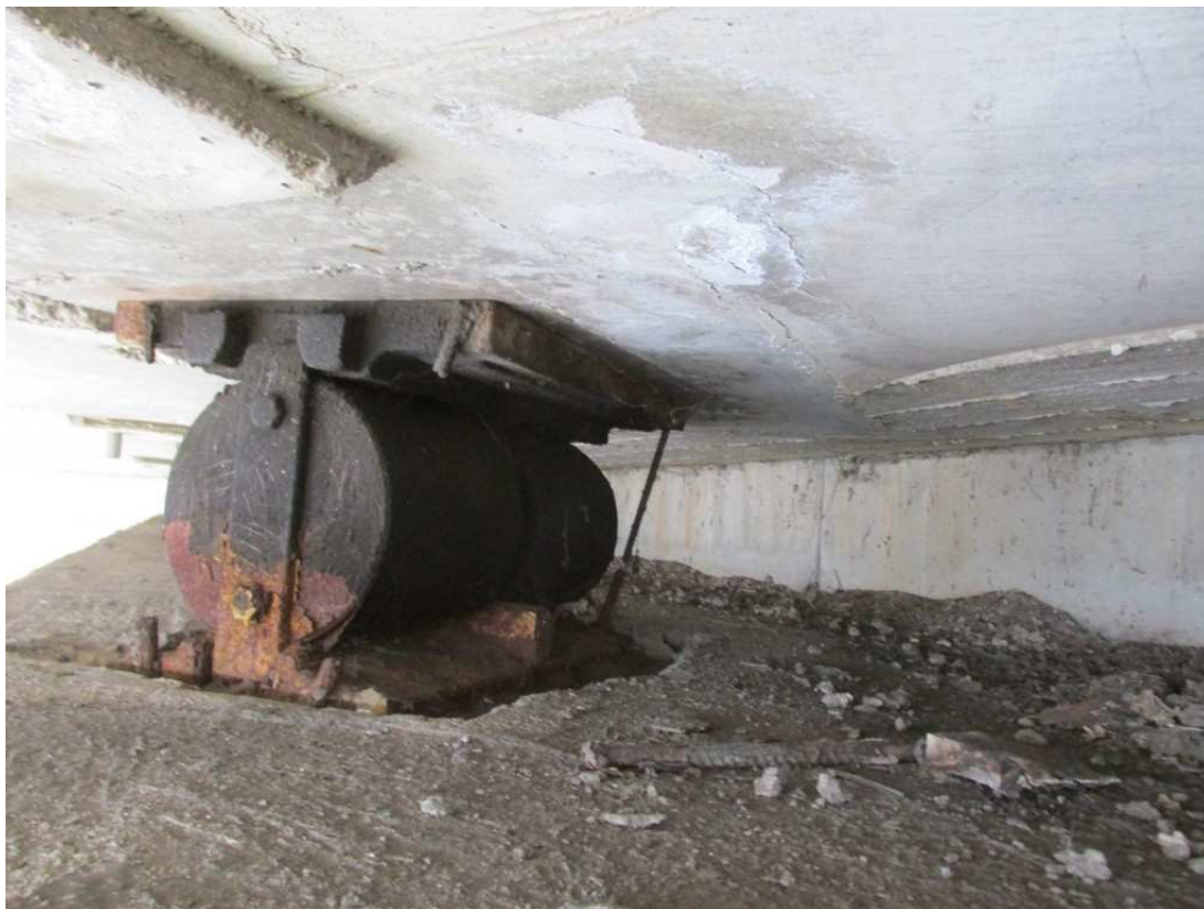
13) Detail na OP3 – uložení a závěrná zídka
