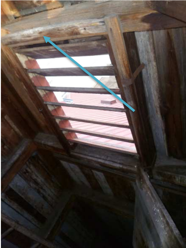
Pozn.13 - demontáž dřevěného rámu nosoucího dvířka
