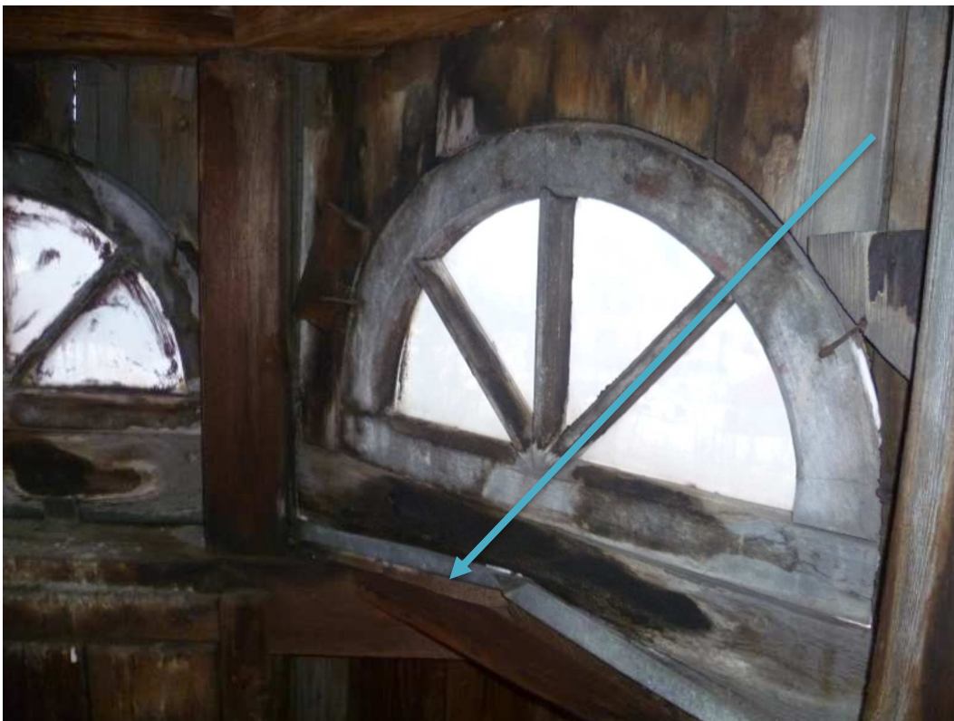
Pozn.56 - částečná výměna poškozených dřevěných prvků parapetu pod okny za nové
