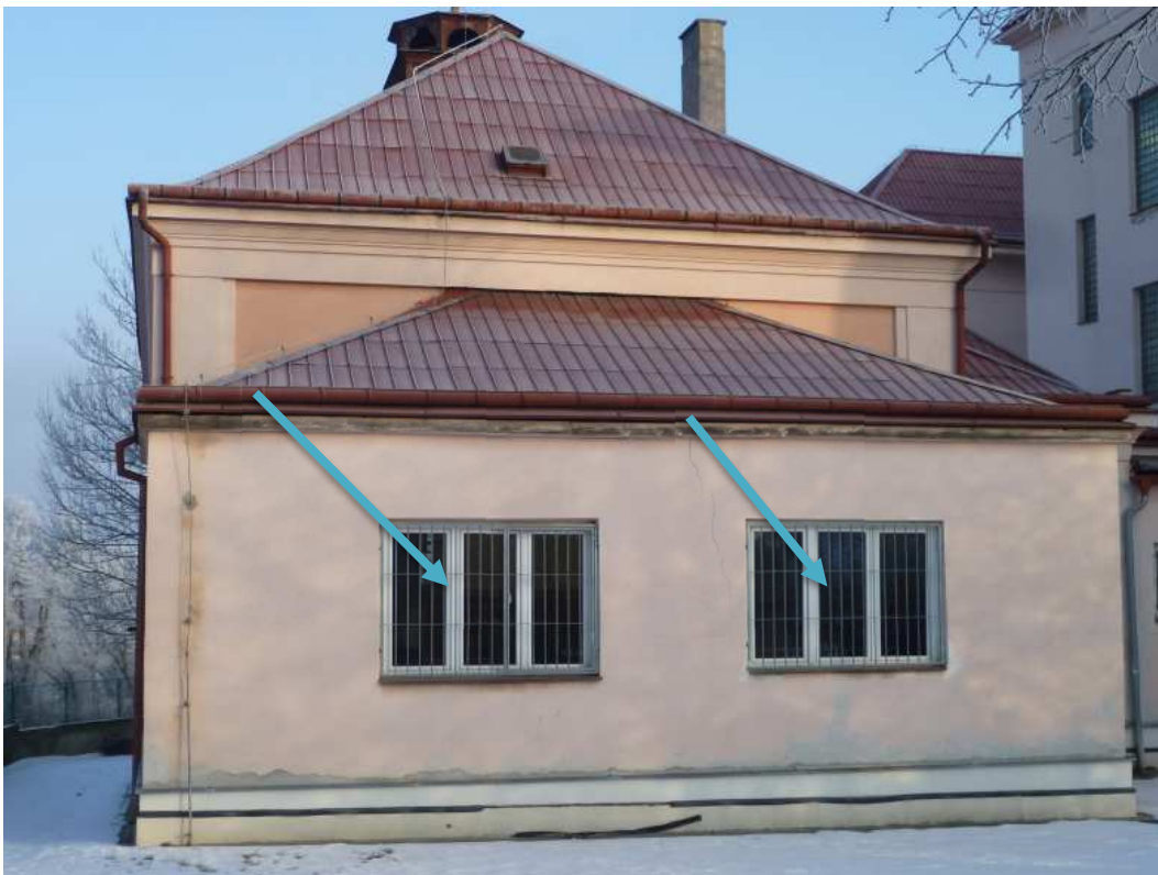
Pozn.80 - zpětná montáž stávajících žárově pozinkovaných mříží oken.
