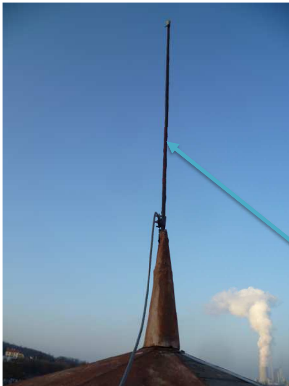
Pozn.64 - nová jímací tyč hromosvodu, žárově zinkovaná, možno opatřit nátěrem dle volby investora a odboru památkové péče.
