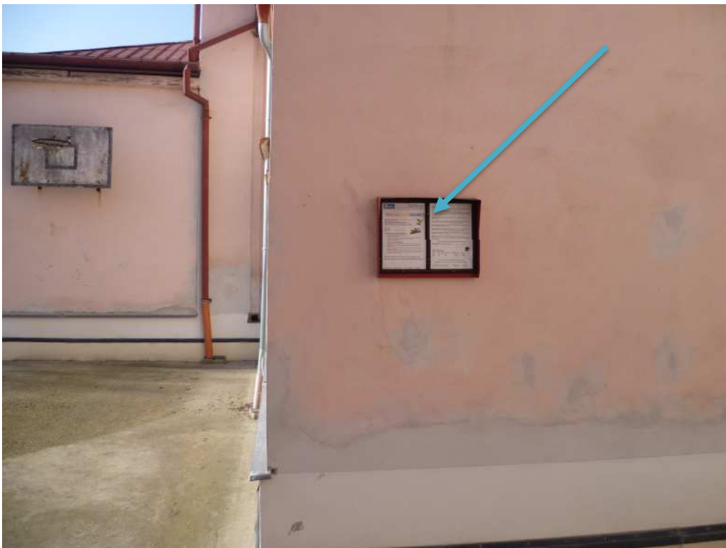
Pozn.18 - demontáž a zpětná montáž tabule provozního řádu dětského hřiště.
