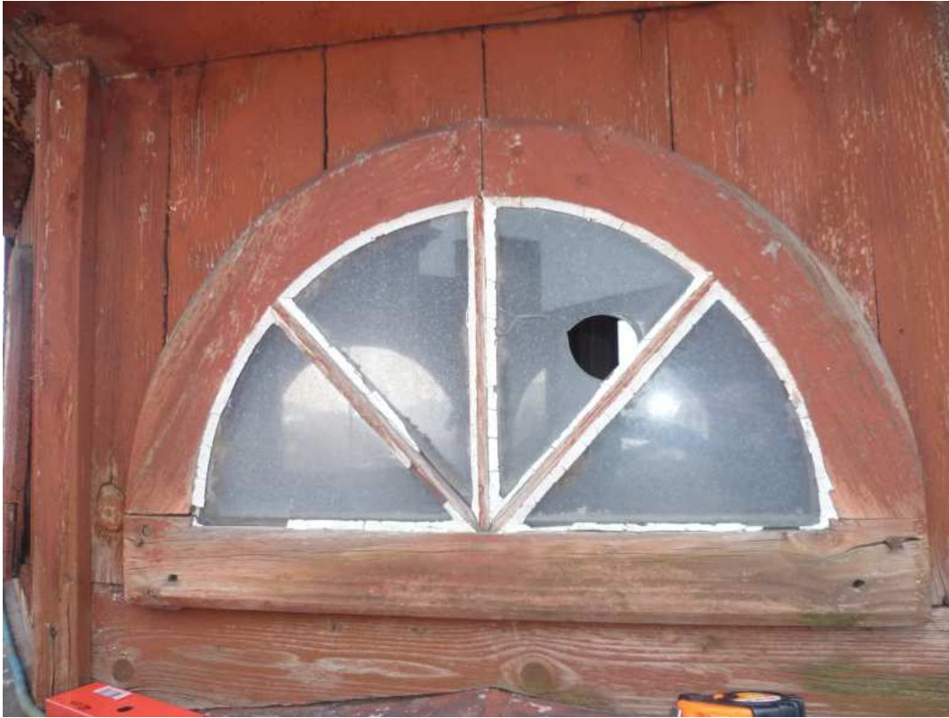
Pozn. 5 - repasování poškozeného okna, předpoklad 100%
