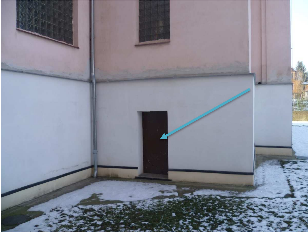
Pozn.71 - stávající dveře budou obroušeny a natřeny barevným nátěrem barvě dle investora a odboru památkové péče.
