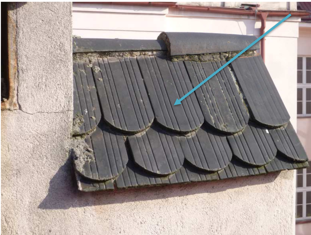
Pozn.86 - osadí se nová střešní krytina - rezná pálená střešní taška bobrovka cihlově červené barvy, pod novou střešní krytinu nebude použita střešní fólie.
