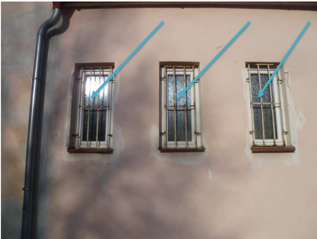
Pozn.30 - demontáž mříží oken, obroušení a žárové pozinkování mříží včetně úchytů.
