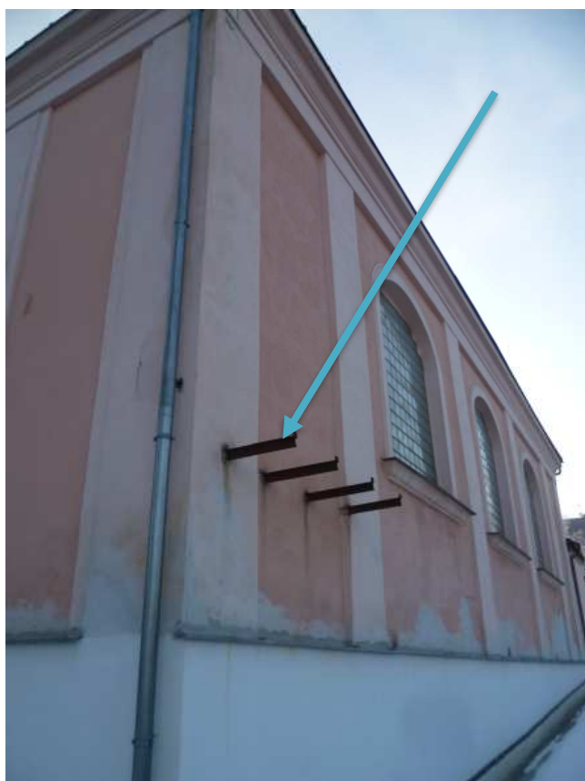
Pozn.32 - odstranění stávajících ocelových kolejnic z fasády. Po odstranění se provede zednické začištění.
