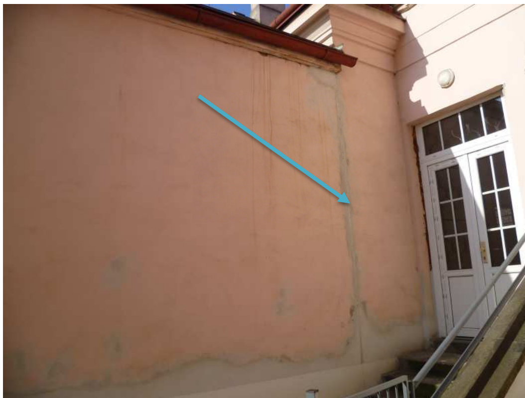
Pozn.28 - dilatační spáry vyčistit.
