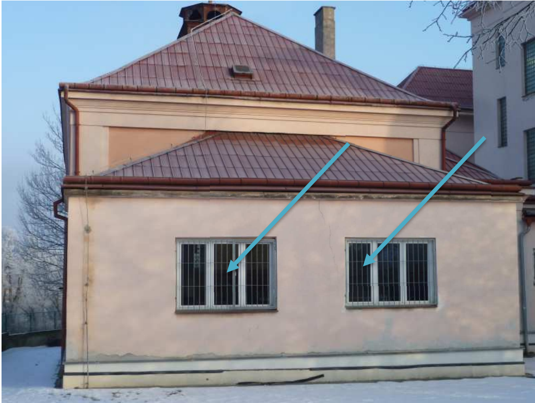
Pozn.29 - demontáž a opětovná montáž mříží oken.
