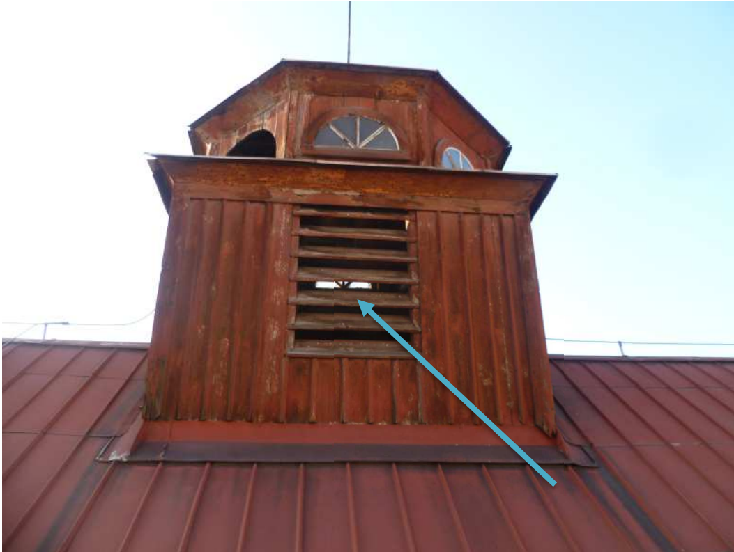
Pozn.11 - výměna poškozeného dřevěného prvku krycího větrací otvor, předpoklad 25%
