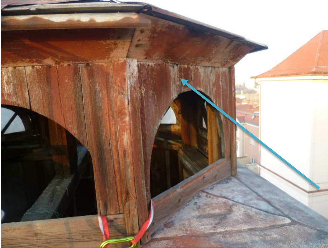
Pozn.53 - nové dřevěné pobití osmistěnné části věžičky z prken tl. cca 18 - 20 mm
