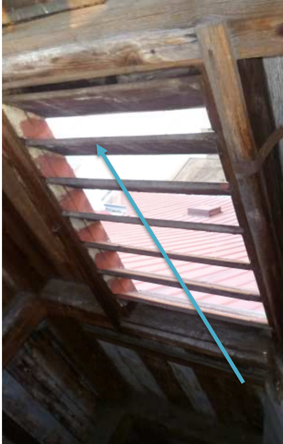
Pozn.63 - montáž nové sítě proti hmyzu s dřevěným rámem z vnitřní strany do prostorů průvětrníků
