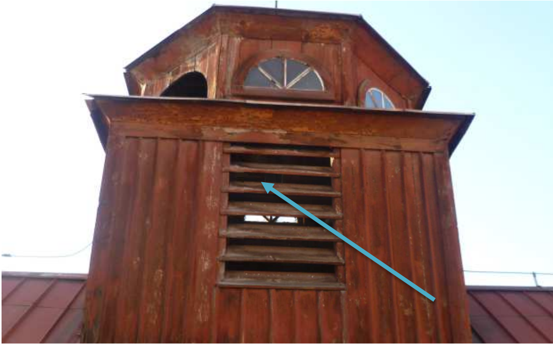
Pozn.61 - částečná výměna dřevěných prvků krycího větracího otvoru z prken tl. cca 16 mm.
