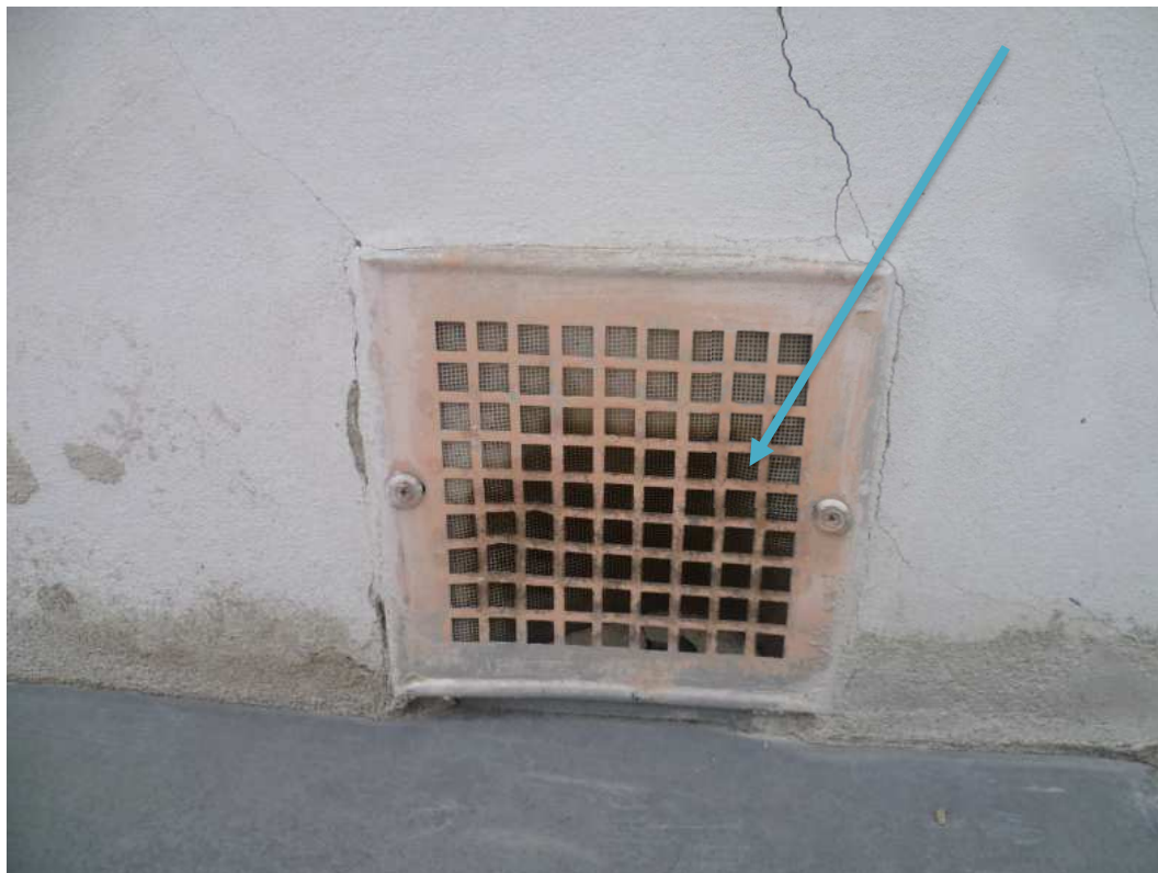
Pozn.33 - demontáž stávajících kovových větracích mřížek.
