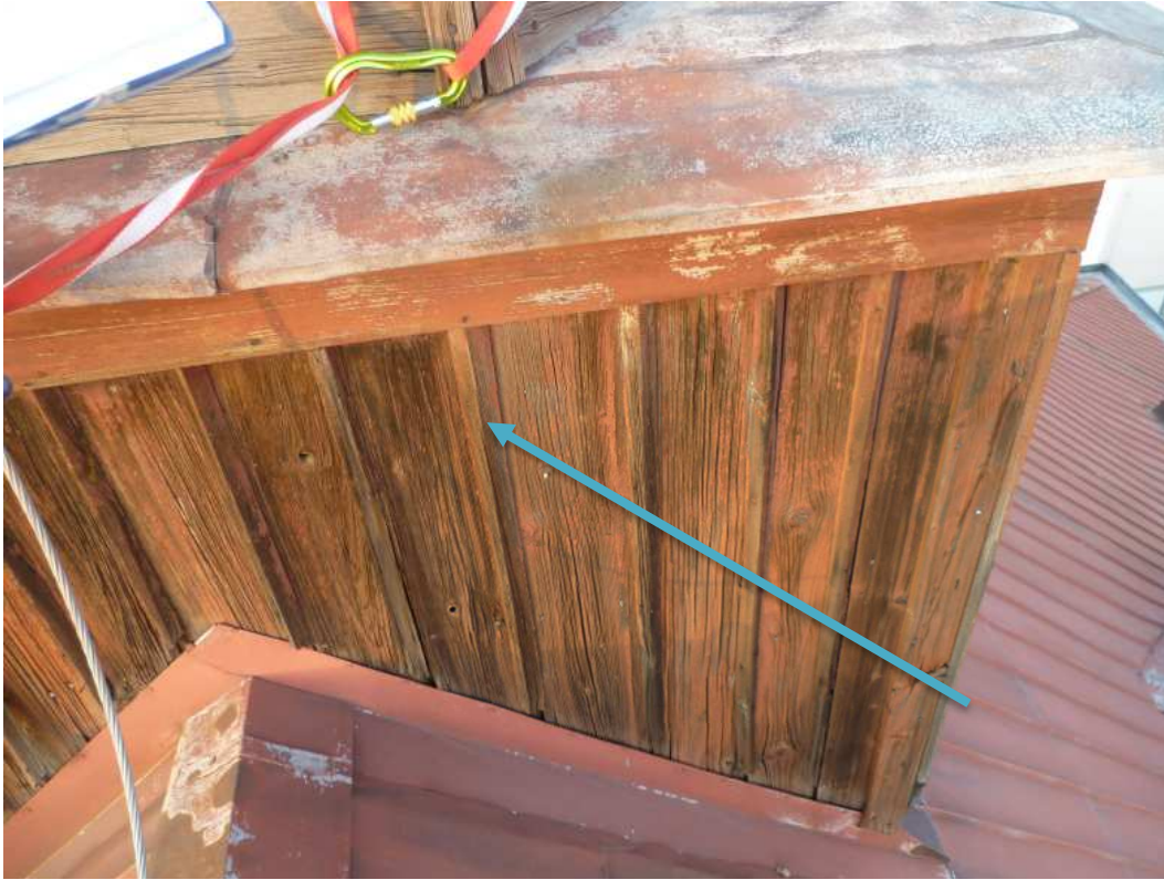
Pozn.59 - částečná výměna zdobných trojúhelníkových prvků pobití čtvercové části
