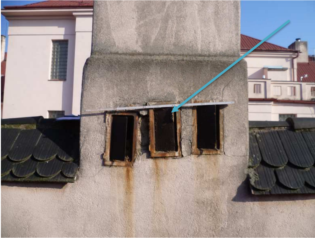
Pozn.87 - osadí se nová dvířka vymetacího otvoru na komínovém plášti, včetně zednického začištění.
