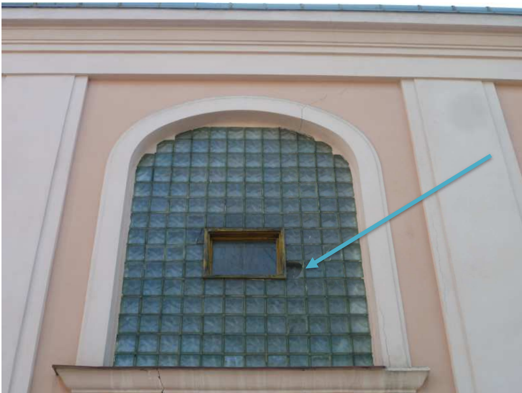
Pozn.72 - provede se oprava poškozených skleněných tvárnic (luxfer 190x190). Poškozené skleněné tvárnice se vymění za nové ve stejné velikosti a dezénu. Před osazením konzultovat nový typ skleněné tvárnice s odborem památkové péče.
