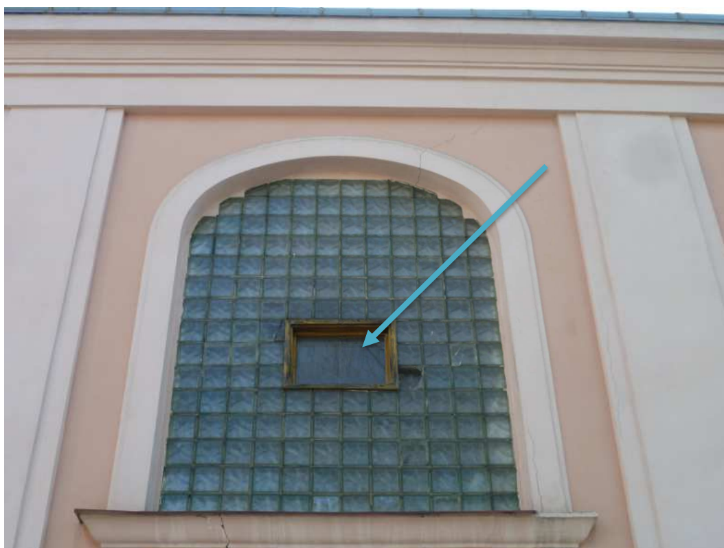
Pozn.36 - vybourání stávajícího dřevěného okna.
