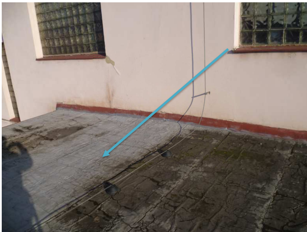
Pozn.22 - odstranění stávající hydroizolační povlakové krytiny (asfaltové pásy).
