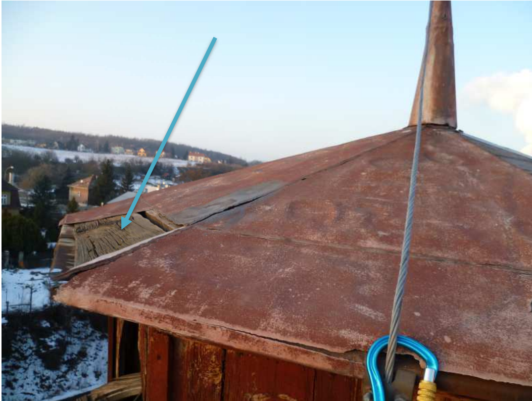
Pozn.51 - nové dřevěné pobití střechy z prken tl. cca 18 - 20 mm
