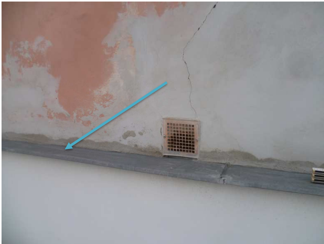
Pozn.16 - demontáž stávajícího oplechování soklu (oplechování je ukončeno pod omítkou).
