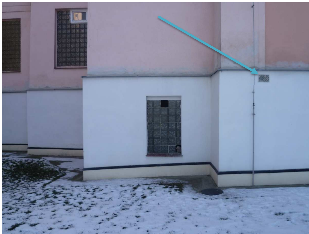
Pozn.34 - demontáž stávající kovové mřížky.
