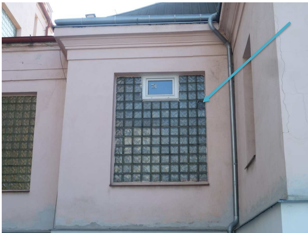
Pozn.27 - demontáž poškozených sklobetonových tvárnic (cca 2-5 ks na jedno okno).
