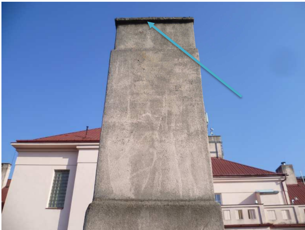
Pozn.40 - odstranění stávající komínové hlavice.
