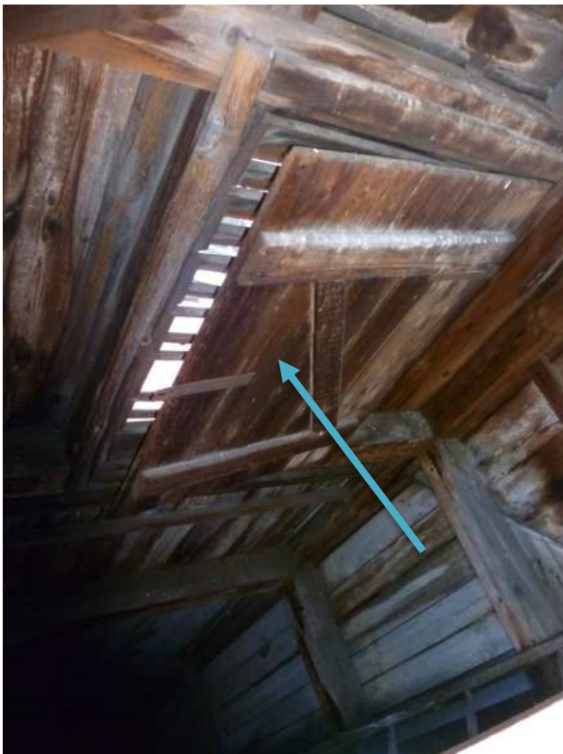
Pozn.14 - demontáž dřevěných dvířek
