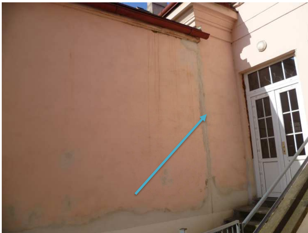
Pozn.66 - po vyčištění dilatační spáry se dilatace provede nová. Do spáry se vloží těsnící provazec mirelon a spára se utěsní trvale pružným tmelem (tmel na bázi MS polymerů).
