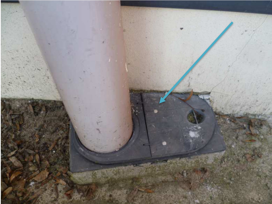
Pozn.17 - demontáž (vybourání) stávajícího lapače střešních splavenin z důvodu nevhodného umístění v těsné blízkosti fasády. Při demontáži bude nutné vybourat i část betonového okapového chodníku.
