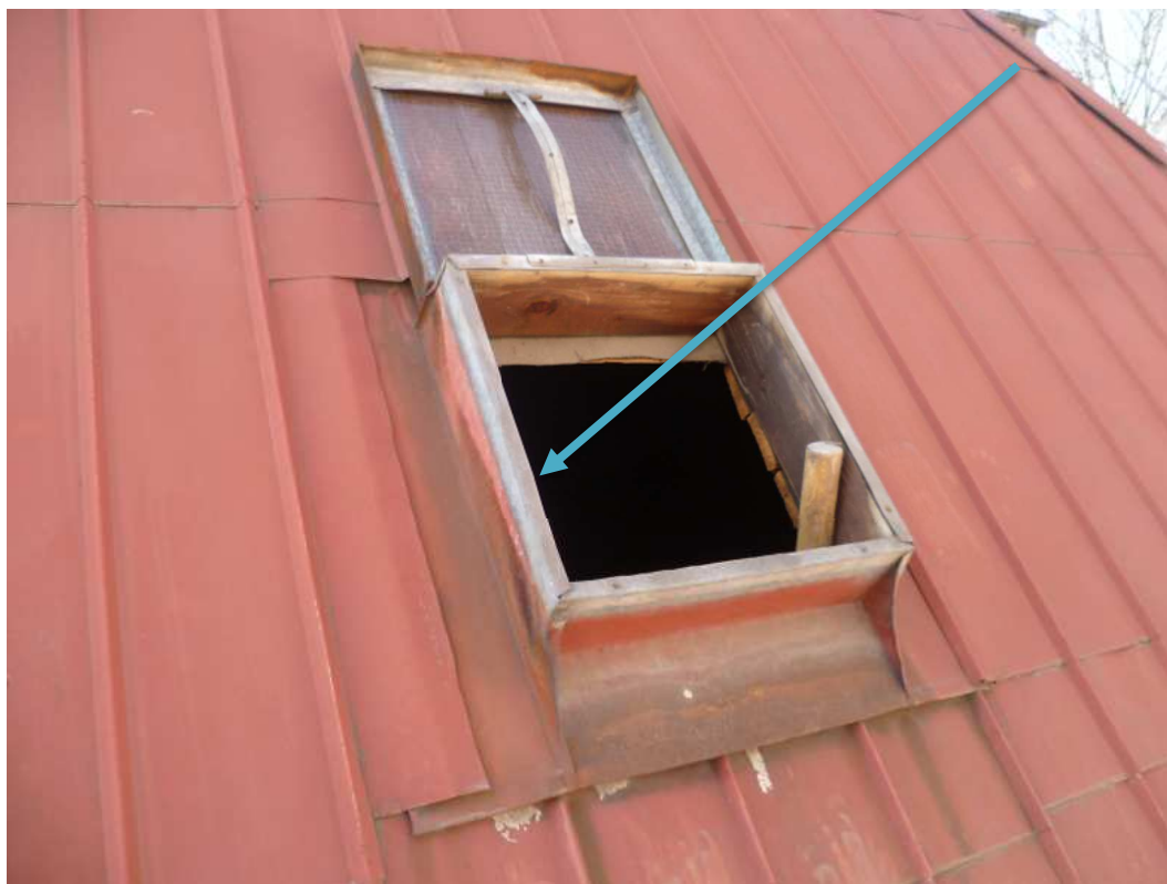
Pozn.23 - demontáž stávajících výleží na střeše.
