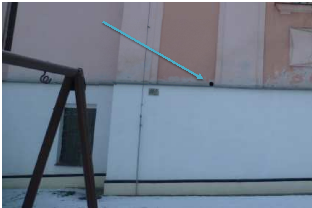
Pozn.35 - zednické začištění otvorů pro osazení nové mřížky.
