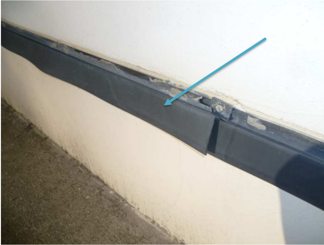
Pozn.15 - demontáž stávající plastové soklové lišty.
