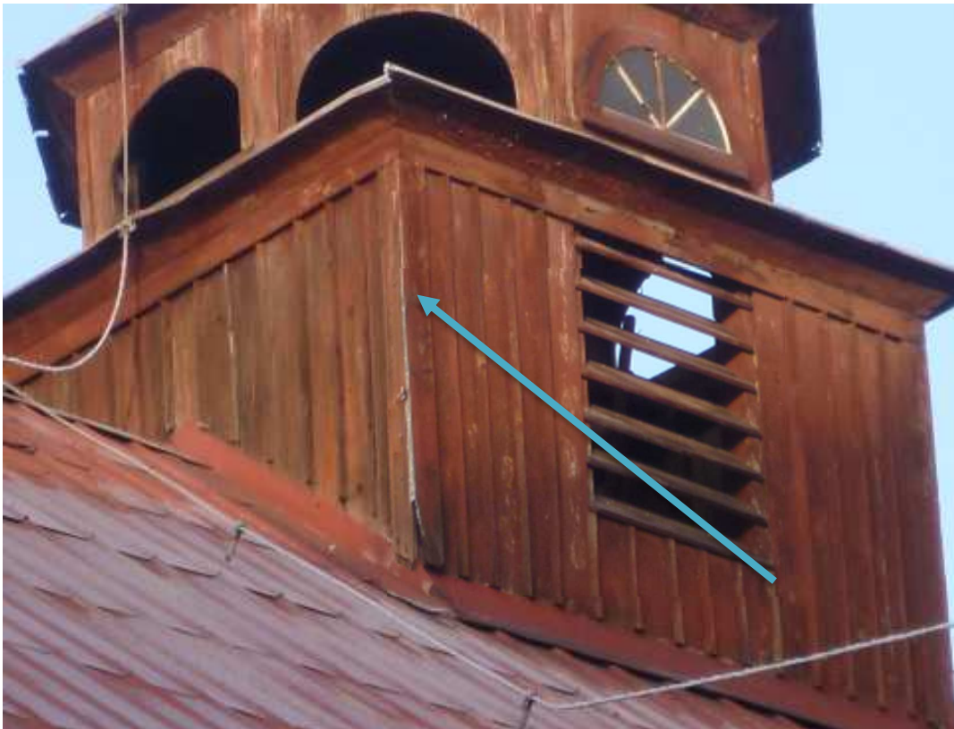
Pozn.62 - nové dřevěné pobití hran nárožní čtvercové nadstřešní části z prken tl. cca 18 - 20 mm.
