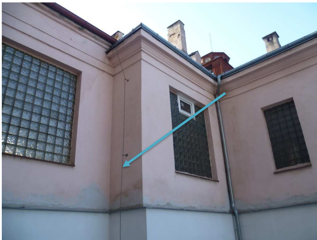
Pozn.21 - demontáž stávajícího hromosvodu.
