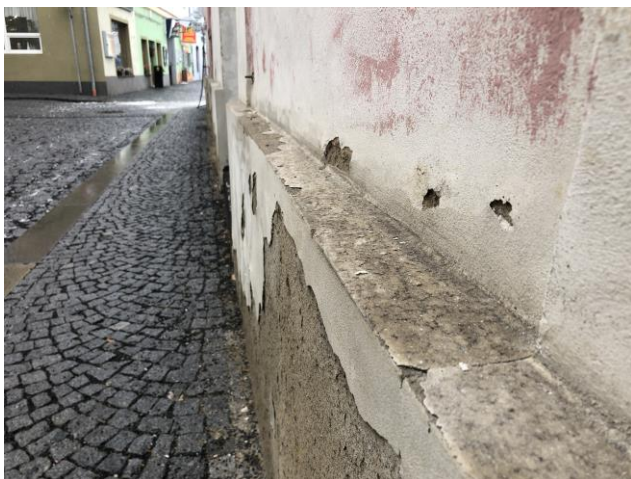
Foto 7: Detail nevhodně spádovaného ukončení soklu u fasády.
