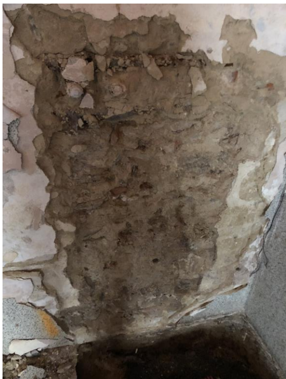
Foto 11: Detail stavu omítkových souvrství na vnitřní nosné svislé konstrukci s viditelnými původními vrstvami omítek a nátěrů pod novějšími vrstvami, odseparovaná omítka a výmalba
