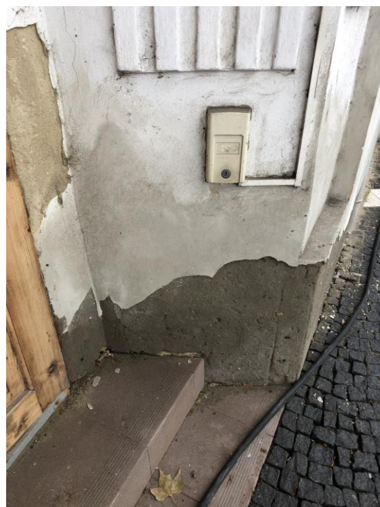
Foto 12: Detail – poškozené omítkové souvrství u hlavního vstupu do objektu
