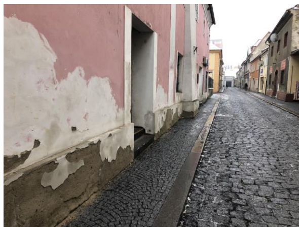
Foto 2: Pohled na fasádu z ulice Komenského. Viditelné vlhkostní projevy na soklu i na fasádě.
