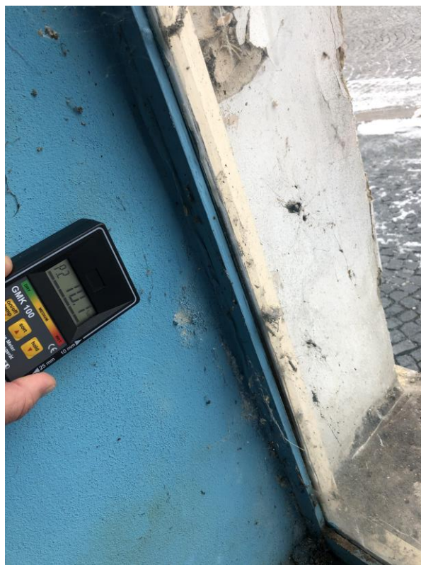
Foto 6: Detail – nedestruktivní měření vlhkosti z interiéru na obvodové svislé konstrukci.
