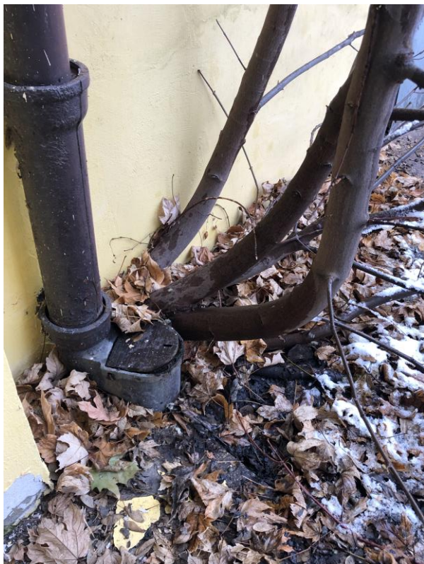
Foto 5: Detail neudržovaného ukončení dešťového svodu ve dvorní části u řešeného objektu. Svod je v tomto místě ucpaný a dešťová voda při dešti přetéká k obvodové zdi. .
