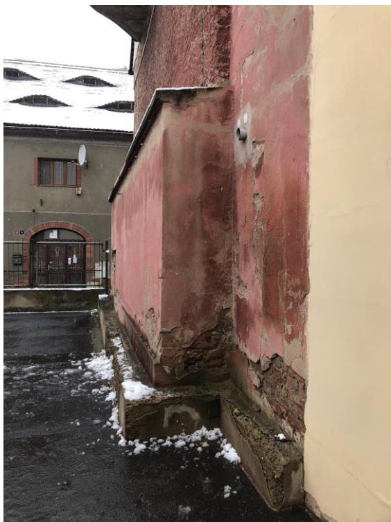
Foto 9: Detail poruch na nevhodně vytvořeném soklu u spodní části svislé konstrukce v jižní části objektu – výrazné poruchy způsobené vlhkostí, nevhodným sklonem soku a odstříkující vodou
