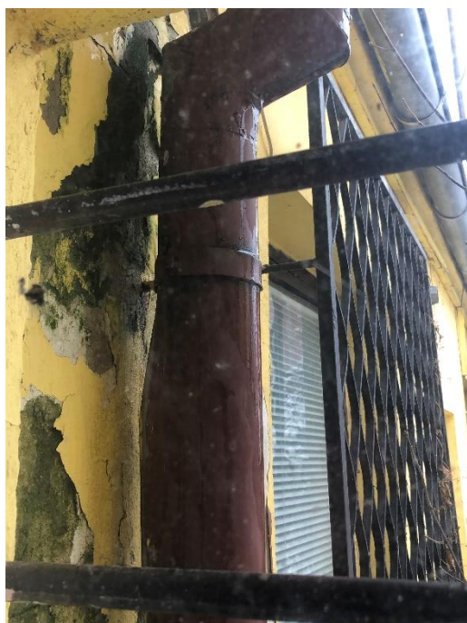
Foto 13: Detail poškozeného dešťového svodu s viditelnými důsledky vniku vlhkosti do fasády ve dvorním traktu řešeného objektu
