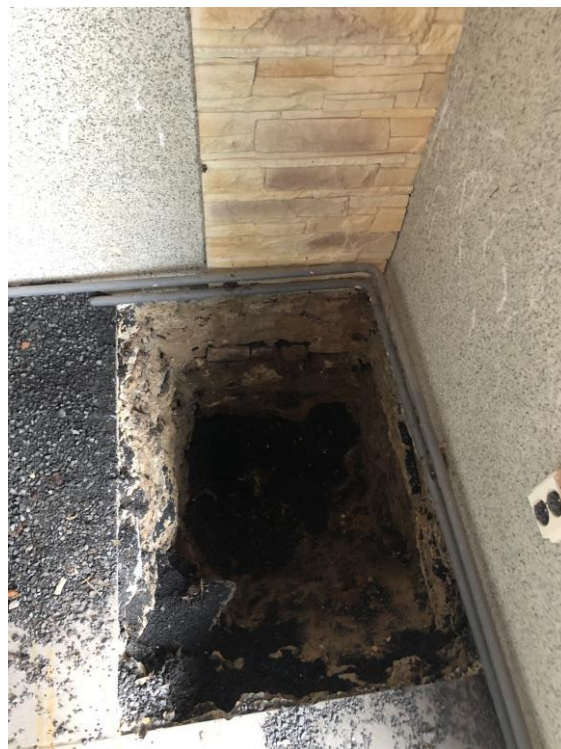
Foto 10: Detail – kopaná sonda v severozápadním koutu prostor 1.NP
