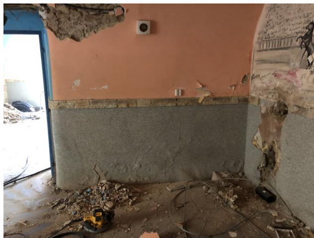
Foto 8: pohled na soklové partie v interiéru 1.NP – nevhodné neprodyšné povrchové úpravy.
