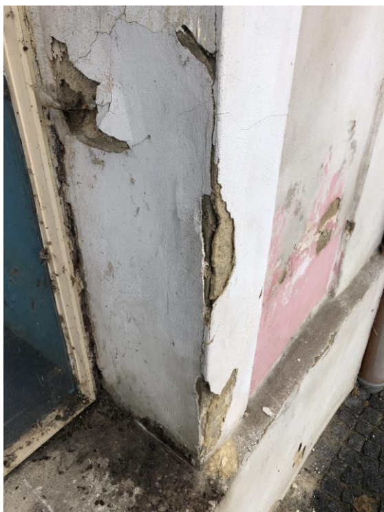
Foto 3: Detail poškozené části fasády nad soklem u stavebního otvoru. Původní omítka pod následnými vrstvami vlivem vlhkost a salinity degraduje.
