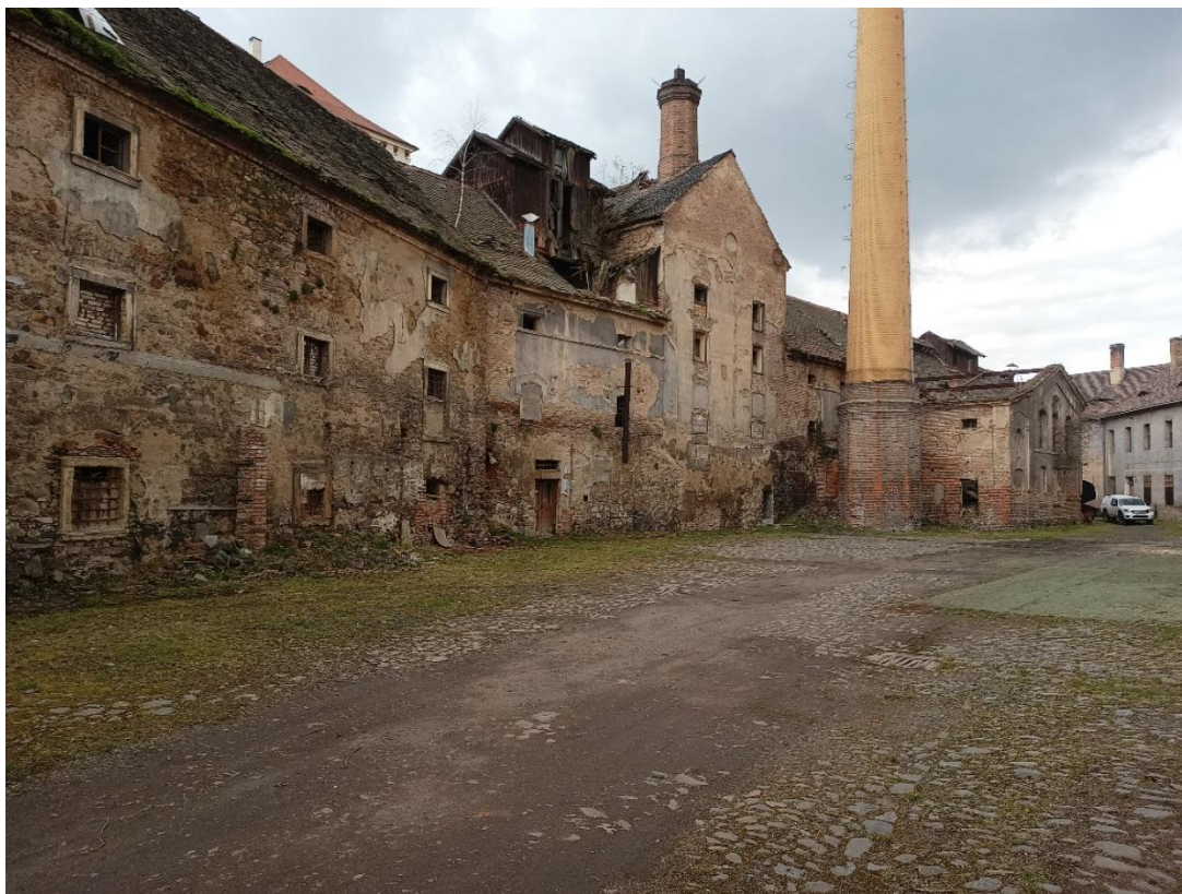
Pohled na hvozdu a kotelnu, horní dvůr
