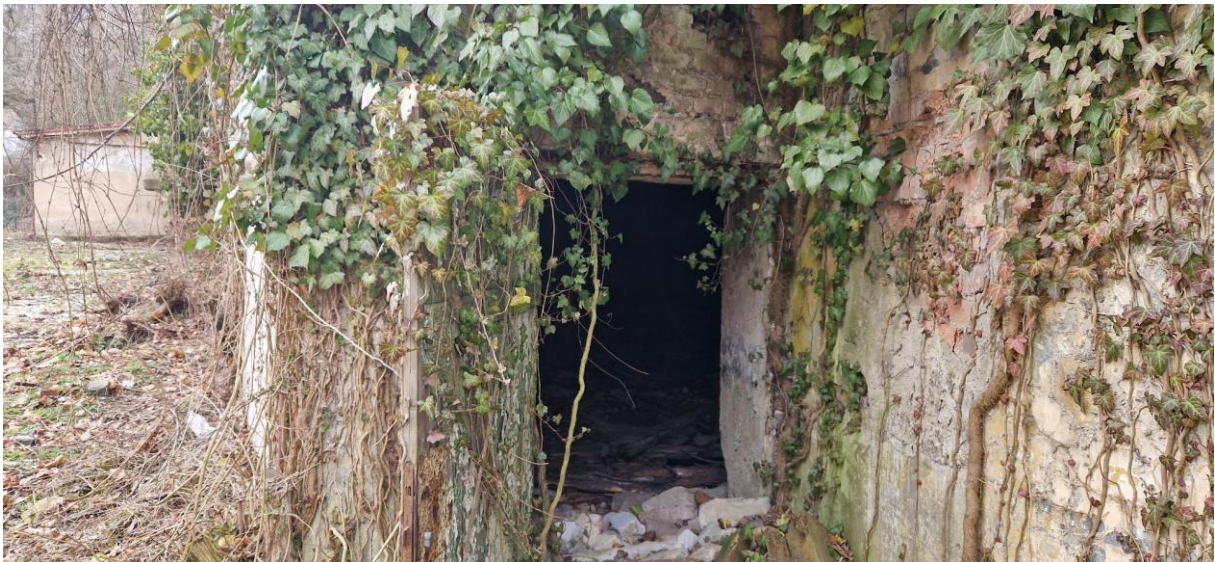
Vstup ze dvora do 1. části sklepů
