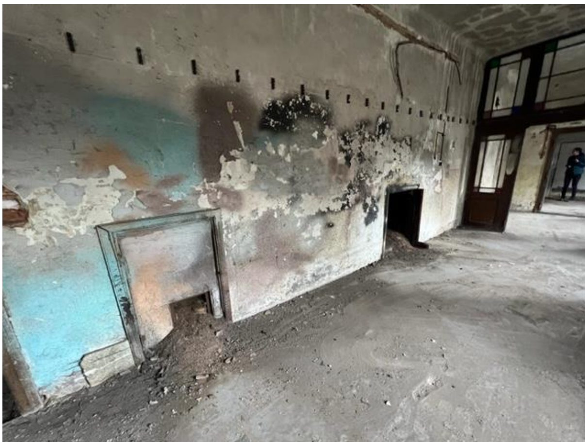
Prostor chodby, č.p.1
