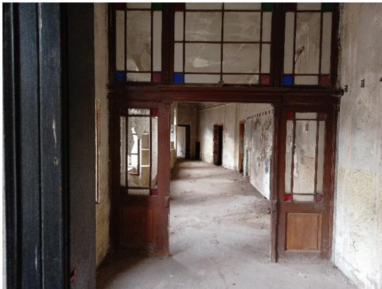
č.p. 1, dveřní předěl chodby
