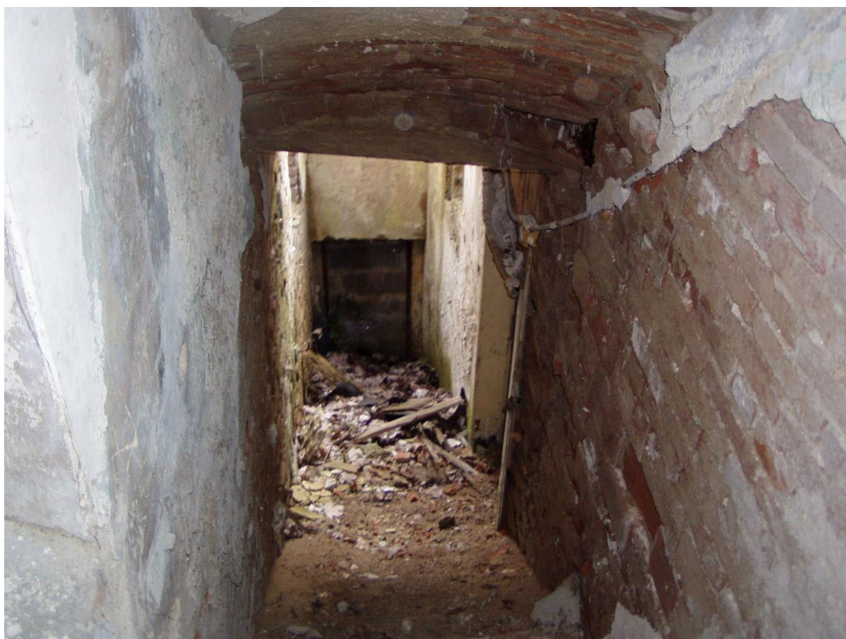
č.p. 2, schodiště mezi 1. a 2. NP
