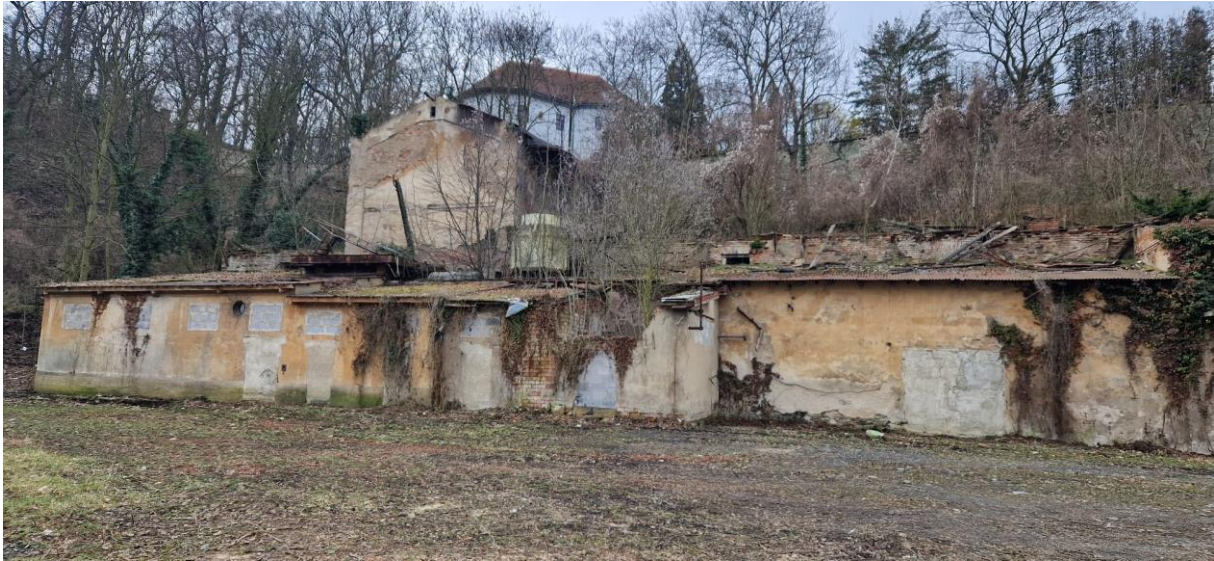
Sklepy, pohled na přístavby, dolní dvůr
