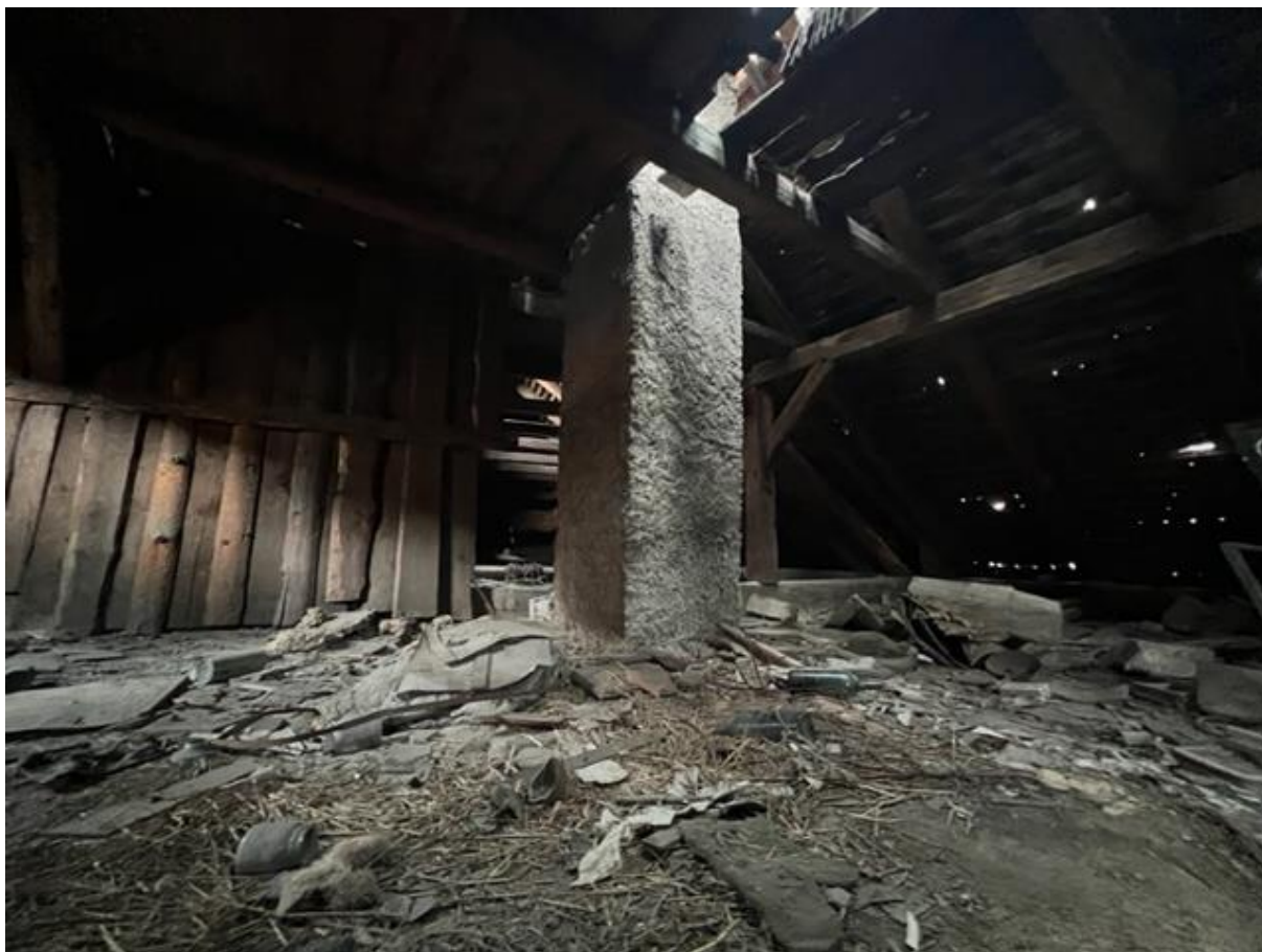
č.p. 1, původní prostor kolem komínového tělesa
