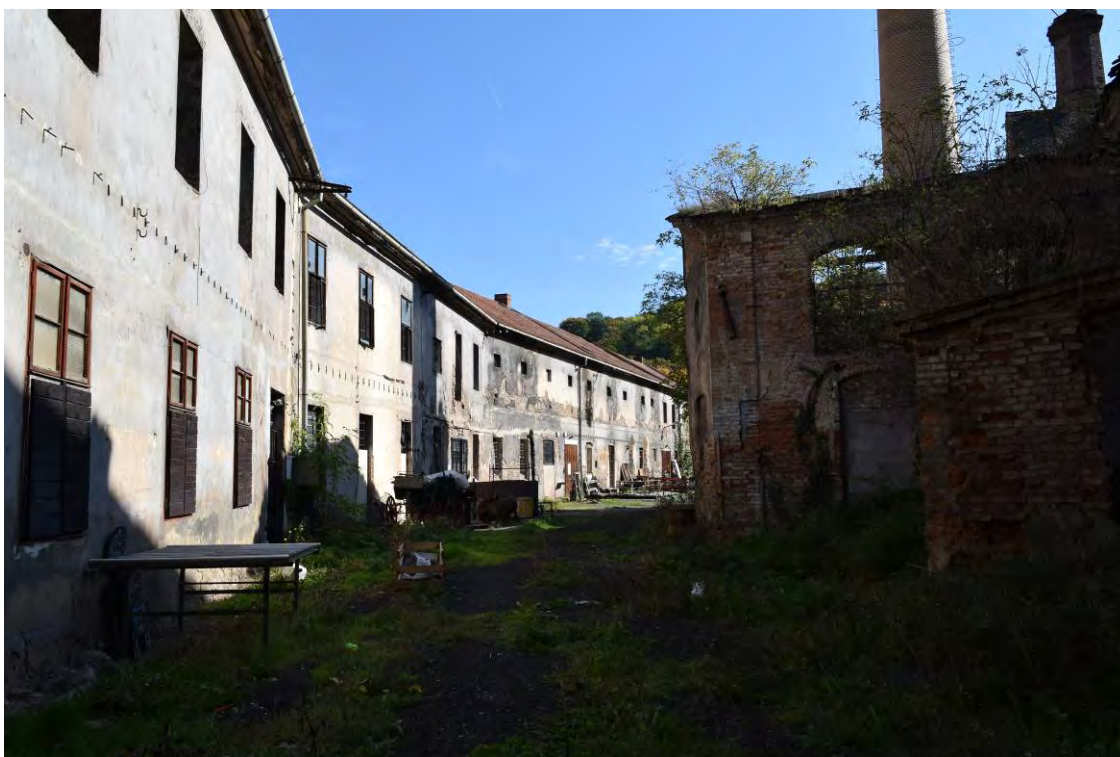
10, pohled na dvorní fasádu čp. 1 směrem od severu.
