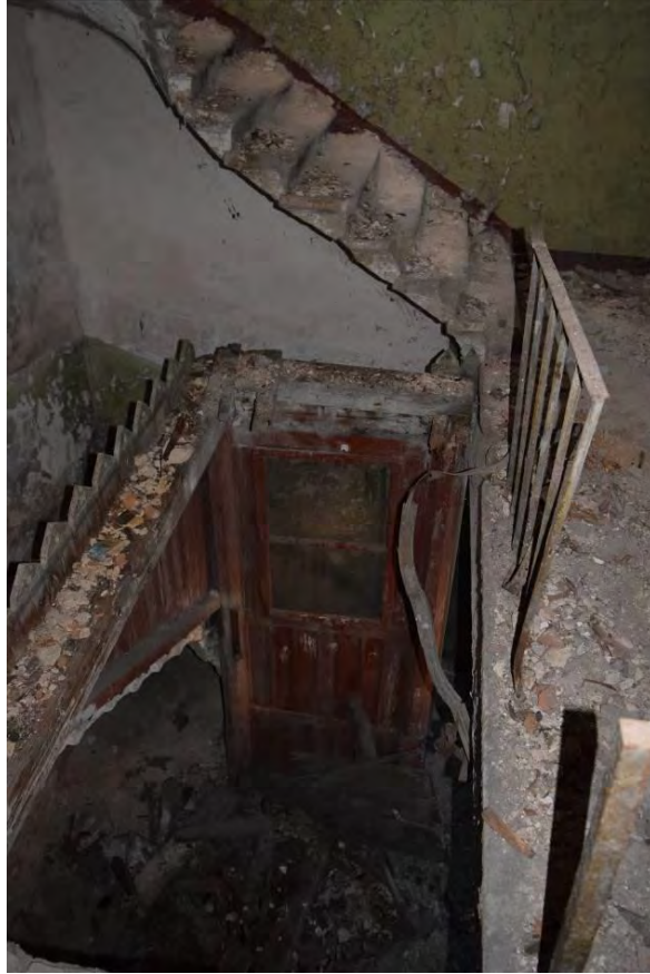
59 , pohled na hlavní schodiště čp. 2 z první podesty. Schodiště má kamenné stupně a jinak už nic.
