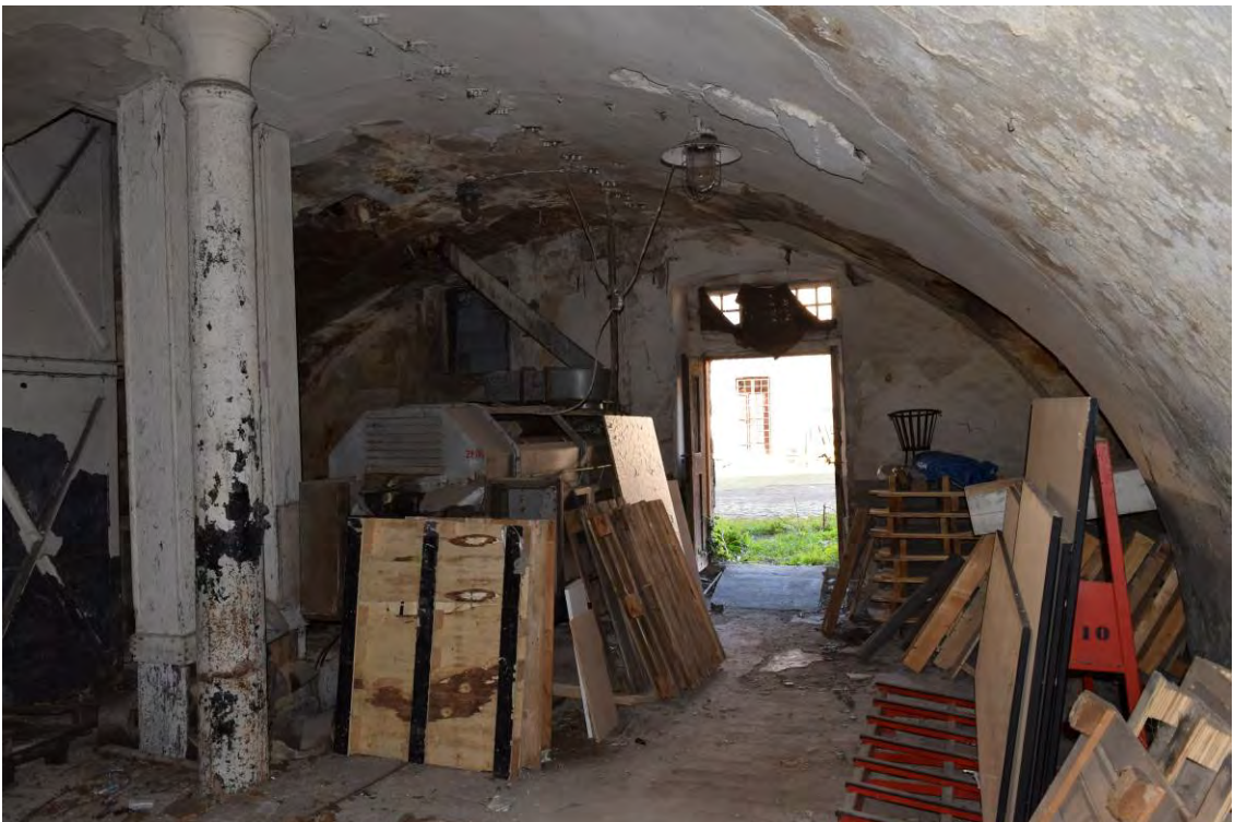
44, pohled do prostoru 1.17 směrem k východní stěně s původním vstupem. Prostor je zaklenut valenou klenbou s dodatečným podepřením železným sloupem.
