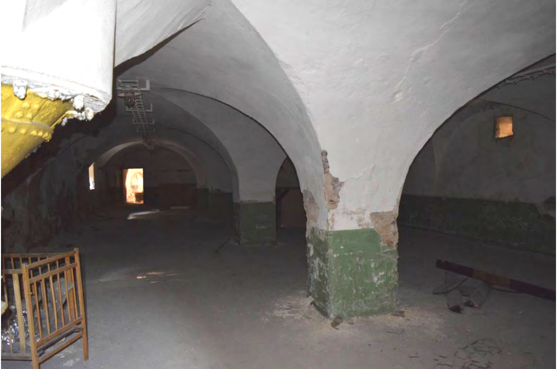
45, pohled do prostoru přízemí čp. 228 části II. Prostor 1.18 je zaklenut valenou klenbou s protilehlými trojbokými výsečemi, kterou uprostřed vynášejí pilíře.
