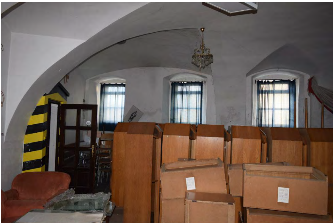
29, Pohled na východní stěnu prostoru 1.2 . Valené klenby s pětibokými výsečemi jsou použity v celém přízemí čp. 1.1.
