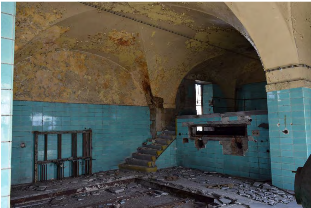
48, celkový pohled do prostoru 2.1 směrem k jihovýchodu. Vidíme křížovou klenbu s vytaženými jemnými hřebínky.
