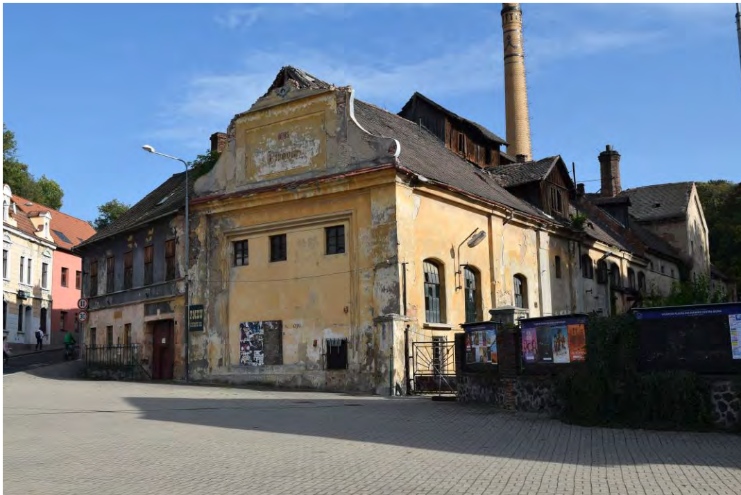
12, pohled na severní část čp. 228 obrácenou hlavním průčelím do Pivovarského náměstí. Průčelí pochází v základním rozvržení z 2. pol. 17. stol.
