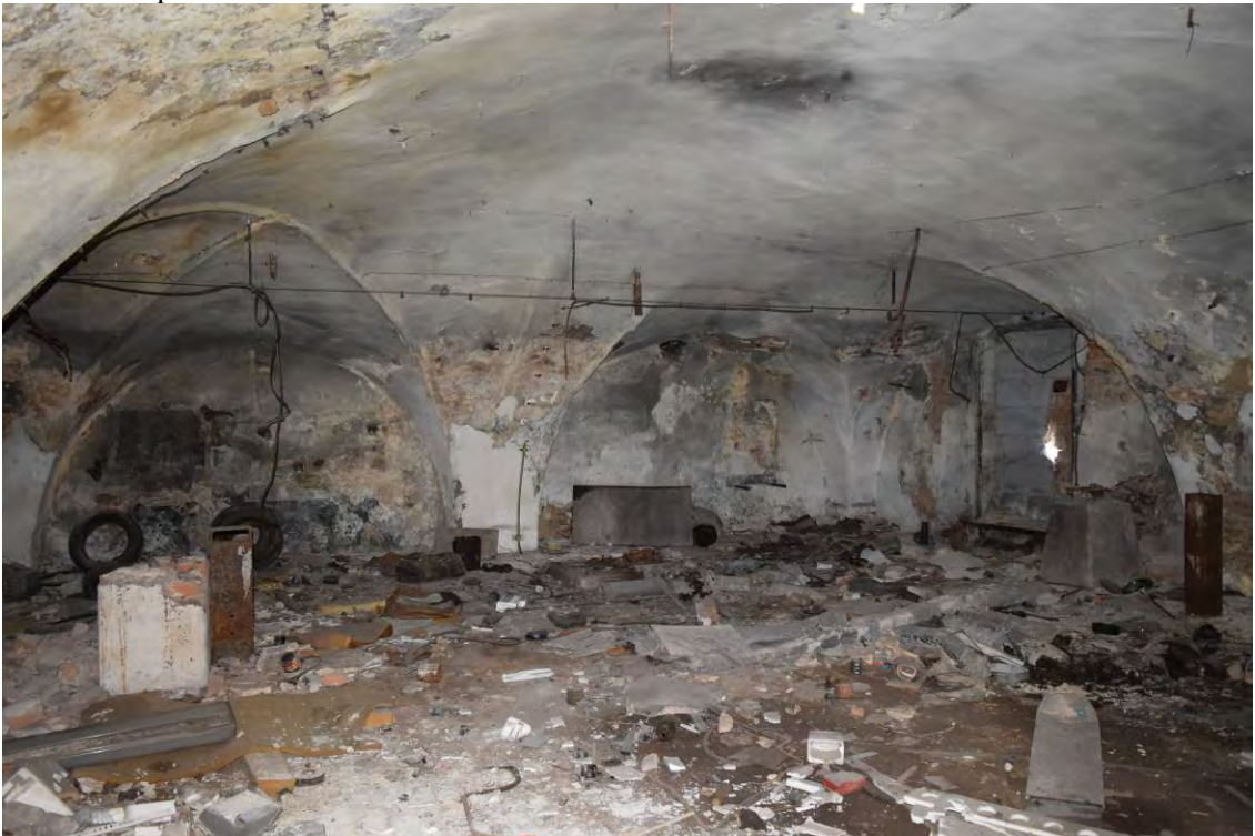
40 , pohled do prostoru 1.8 . Prostor je zaklenut neckovou klenbou, která byla opatřena dřívě štukovými žebry.
