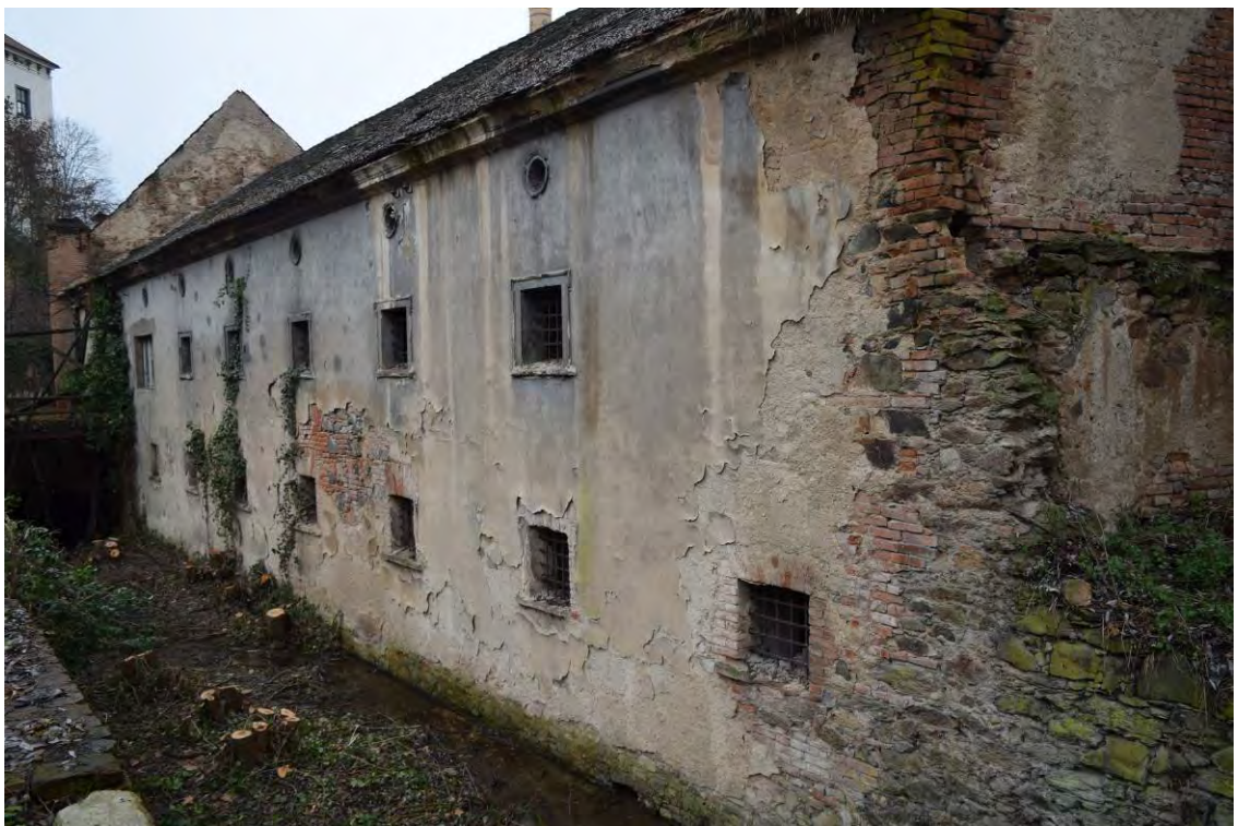
18, pohled na jižní fasádu části III č.p. 228.
