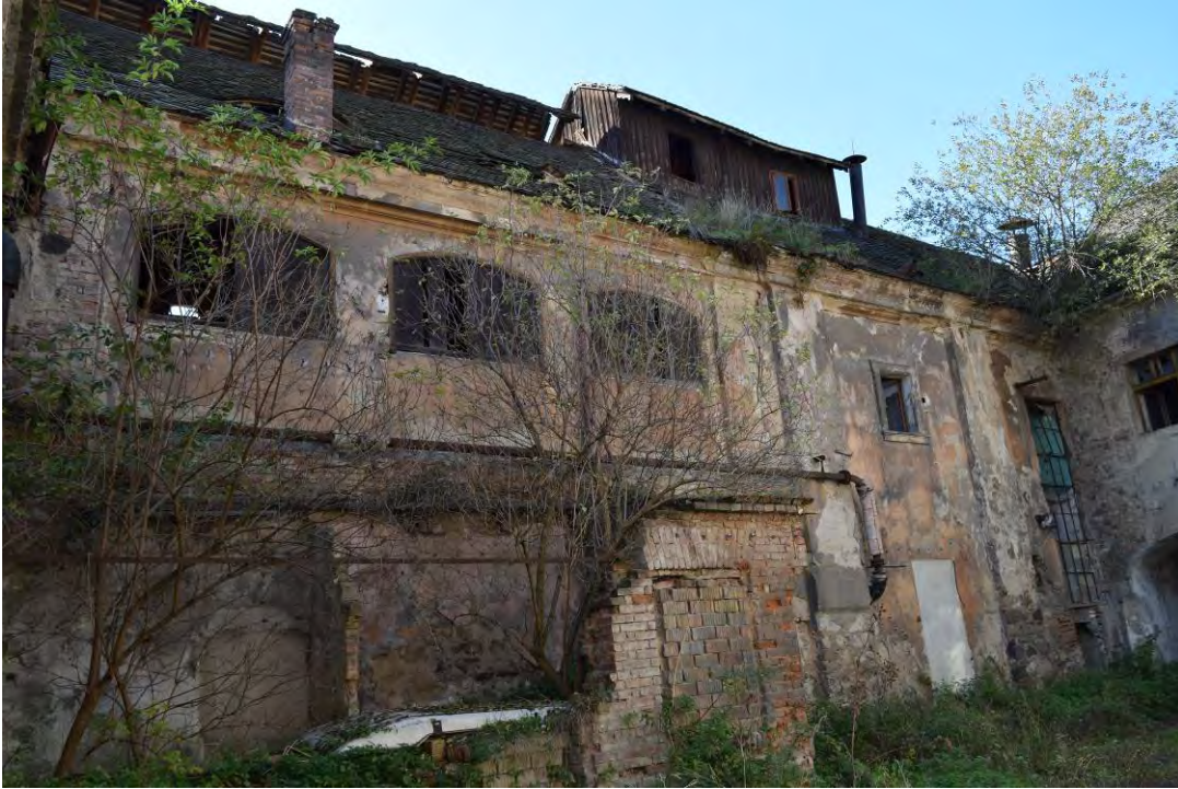
24, pohled na severovýchodní fasádu na severním konci. Segmentová okna původně probíhala až do přízemí.
