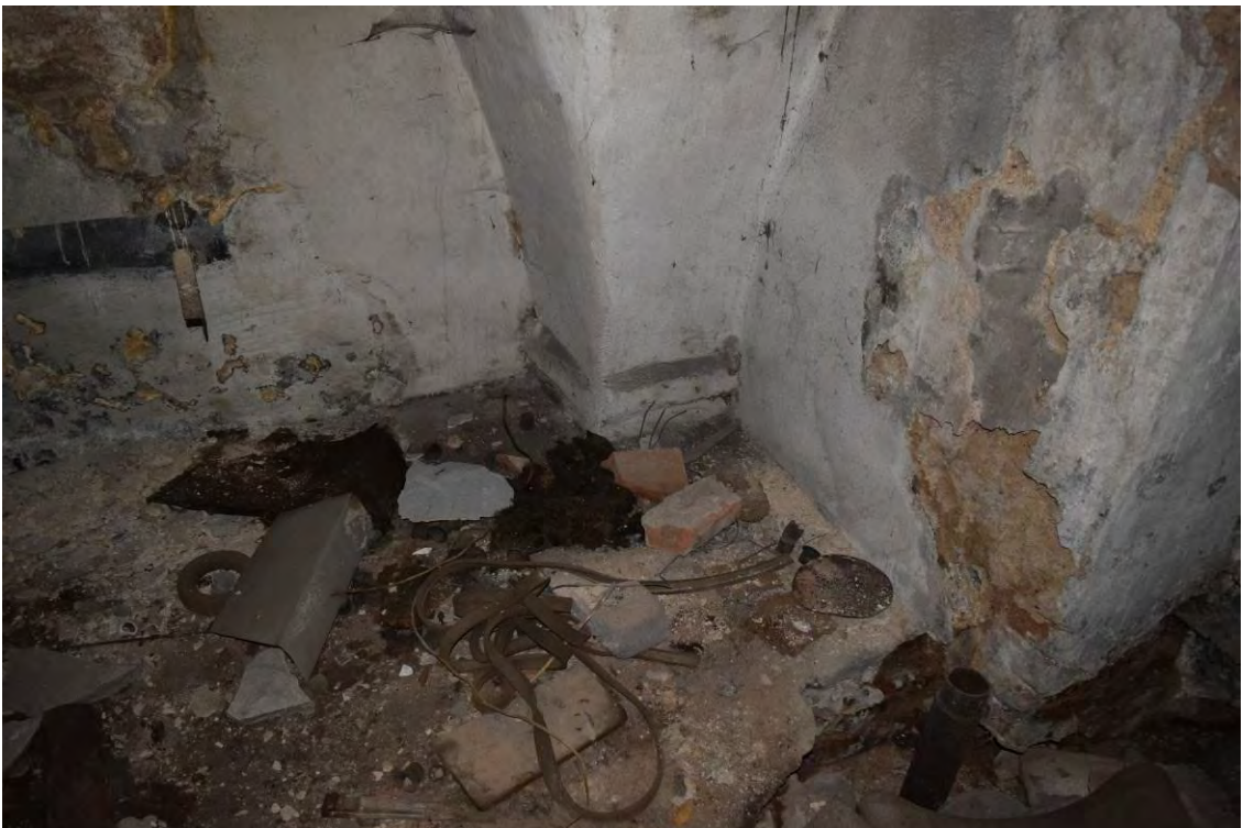
42, detail hlavice přízedního pilíře v jihozápadním rohu. Poloha hlavice ukazuje na dodatečné zvednuté podlahy prostoru, který sloužil jako původně také jako sladovna.
