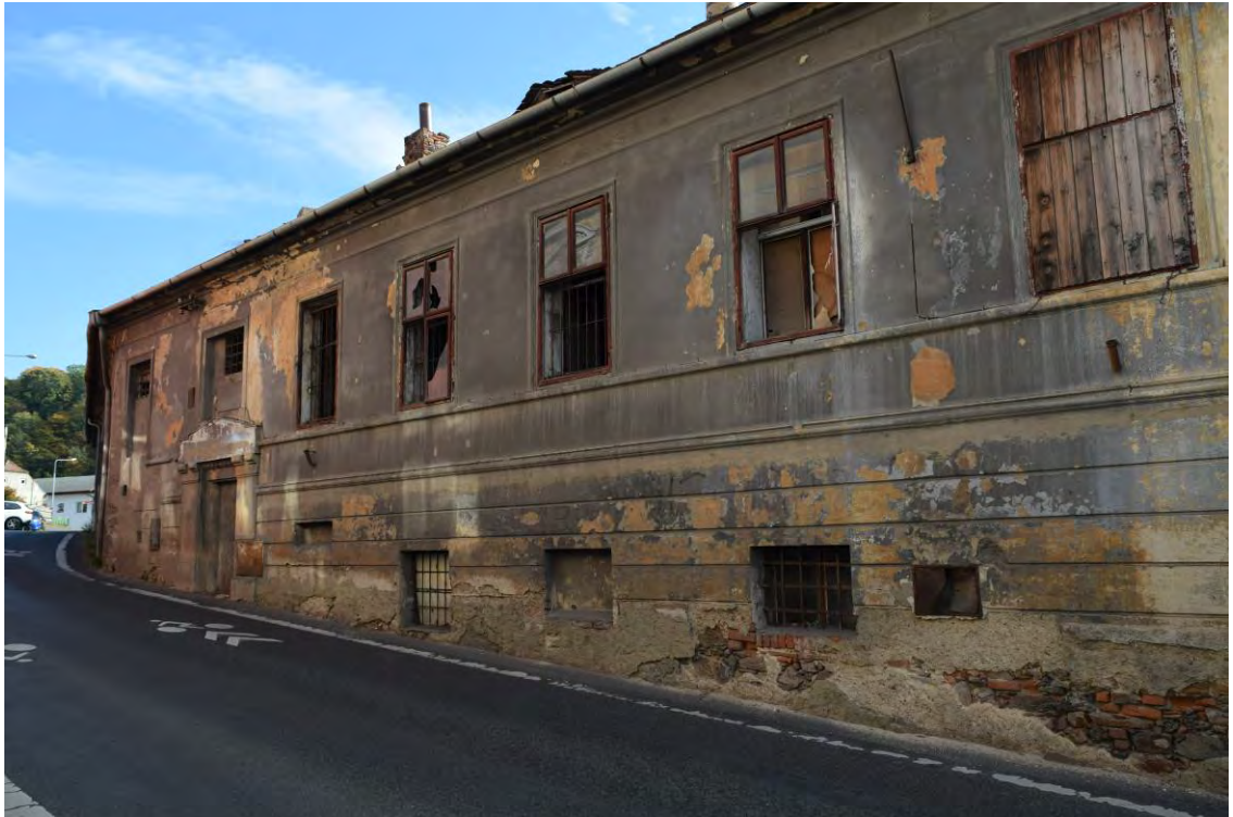
05, pohled na severní část fasády domu čp. obracející se do ulice Litoměřické.
