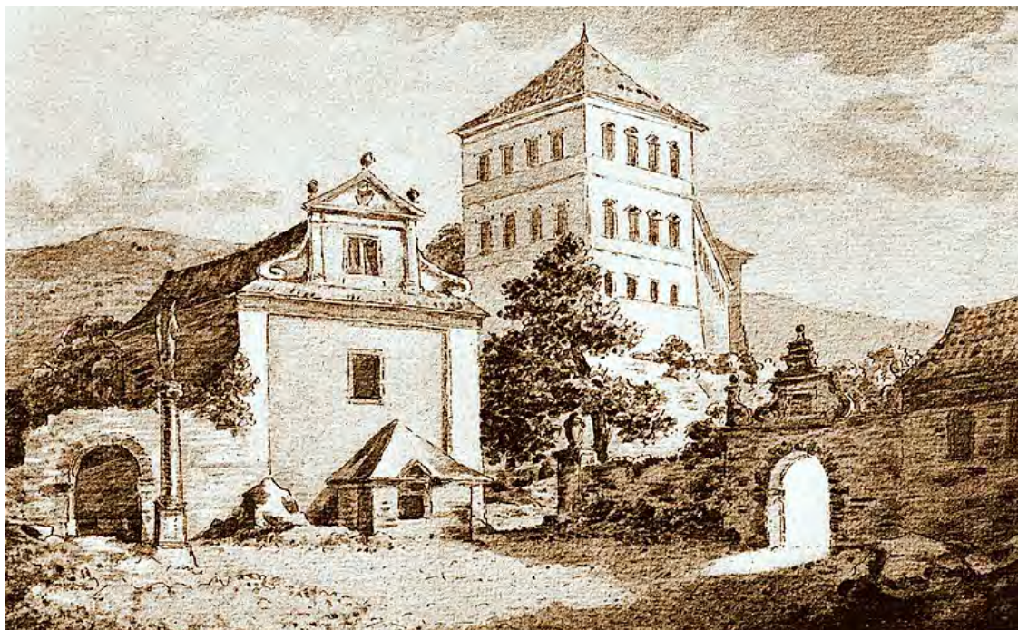
17, kresba zachycující pohled na pivovar z prostoru dnešního pivovarského náměstí. Na pravé straně vidíme zbytek městského opevnění s branou. Budova pozdější varny nese stejnou podobu průčelí, jaká se dochovala v podstatě dodnes. Autorem kresby je podle literatury J. W. Goethe a vznikla ve druhém desetiletí 19. století. Převzato: Bílinsko očima původních německých obyvatel, Bílina 2006, s. 13.
