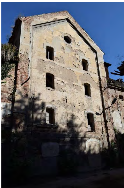
15 , pohled na jihozápadní fasádu hvozdu se sušárnou. Na této straně hvozdu je dochována původní podoba okenních otvorů.
