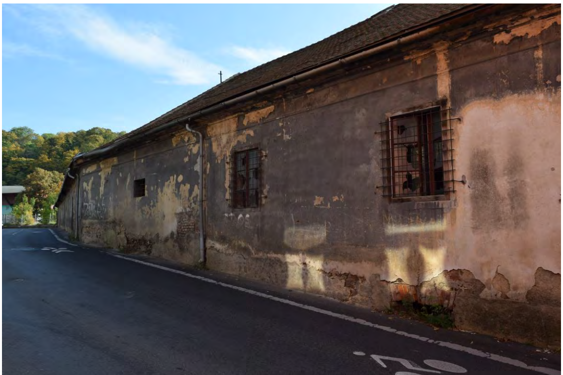
06, pohled na střední část fasády čp. 1 do ulice Litoměřické.
