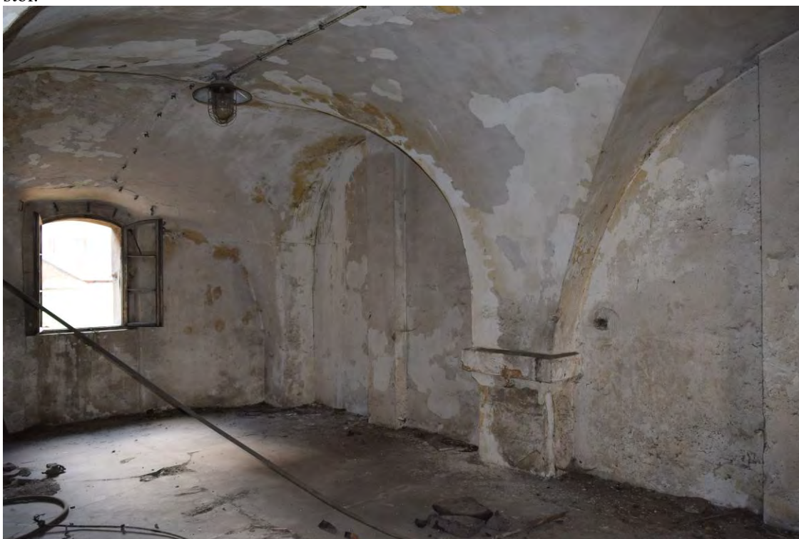
50, pohled do severozápadního rohu prostoru 2.2 . Tento prostor byl původně otevřený stejně jako 2.1. Zazdění arkád a podlaha pochází z pozdějších úprav provedených v 19. a 20. stol.
