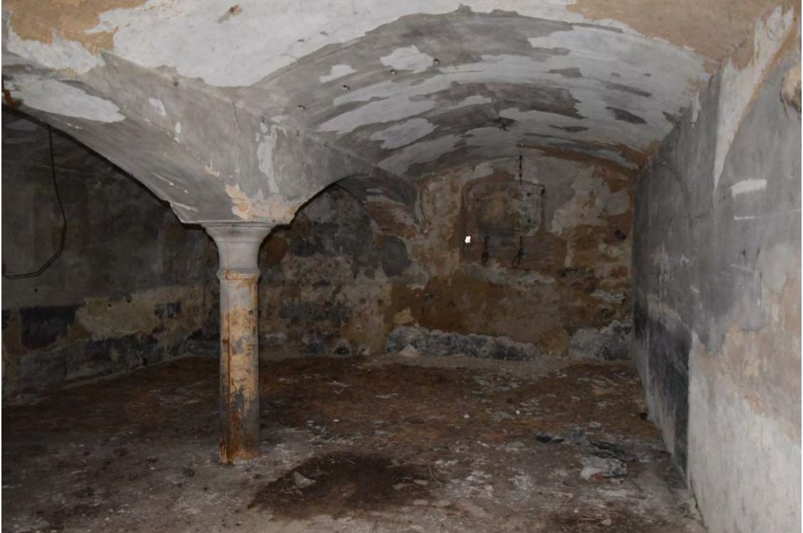
43, pohled do prostoru 1.10 směrem k východu. Prostor je zaklenut vloženými segmentovými klenbami spočívajícími na pasech s litinovými sloupy.
