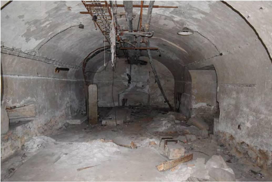
57, pohled do prostoru bývalých ležáckých sklepů směrem k severu. Prostor 1.2.
