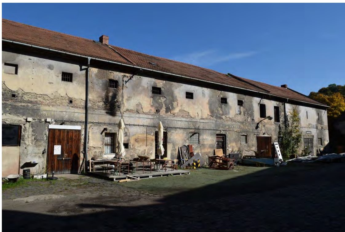
08, pohled na jižní část dvorní fasády čp. 1.
