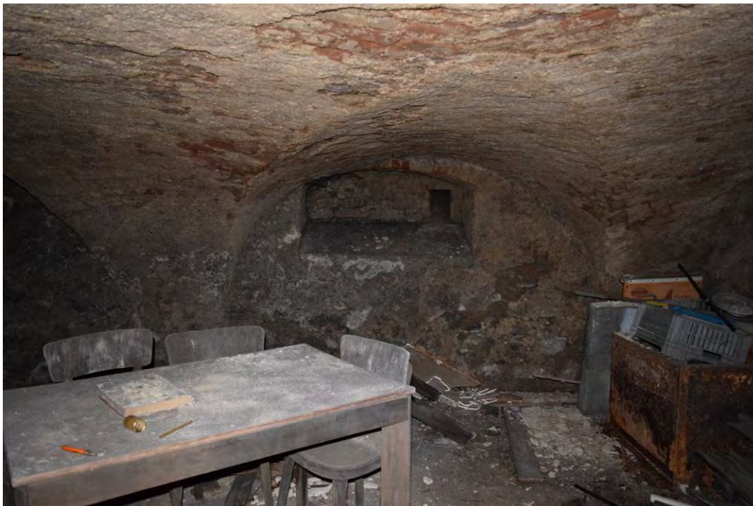
27, pohled na východní stěnu sklepení čp. 1 se zadržím segmentovým oknem.
