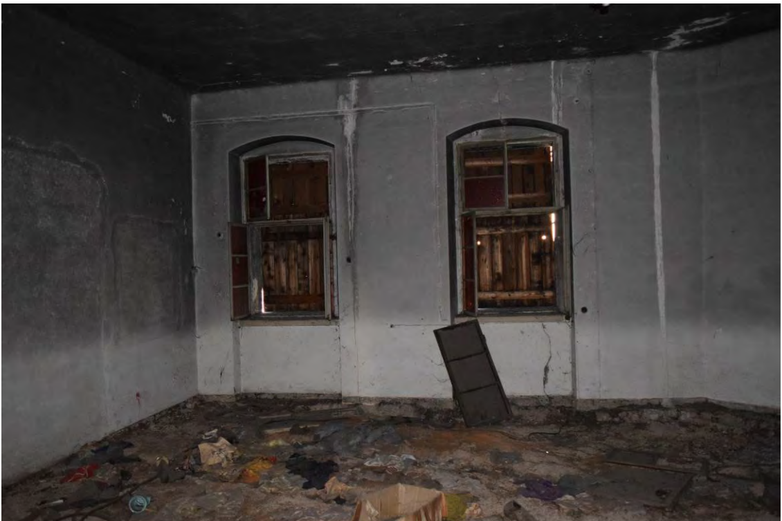
32, pohled na východní stěnu prostoru 2.3 . Okna mají pro toto křídlo typické řešení obdélných oken vložených do segmentových nik.
