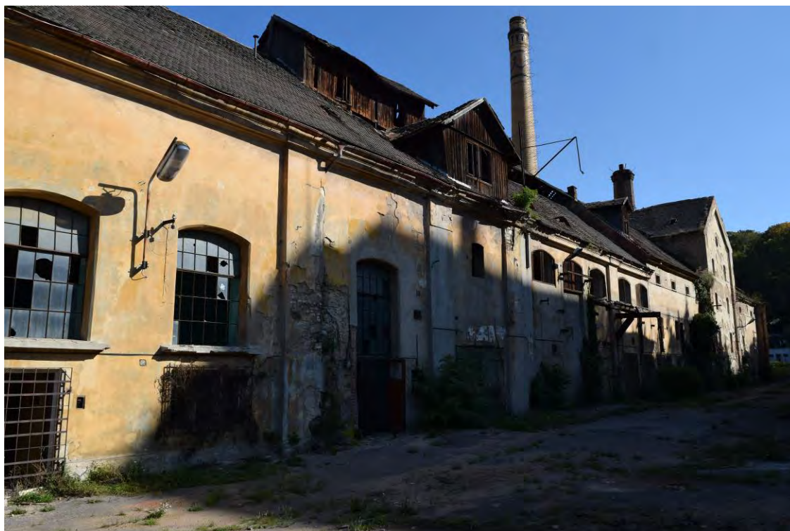
14 , celkový pohled na západní fasádu čp. 228 směrem od severu. Za varnou vlevo následuje bývalá strojovna, spilka s humnem (sladovnou), později prostorem k vymývání lahví a hvozdu s převýšeným štítem.
