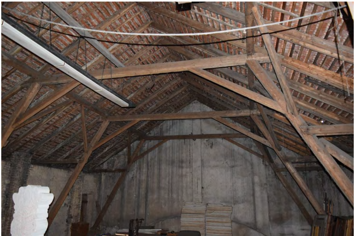
38, pohled do prostoru podkroví 2.21 směrem k severu.
