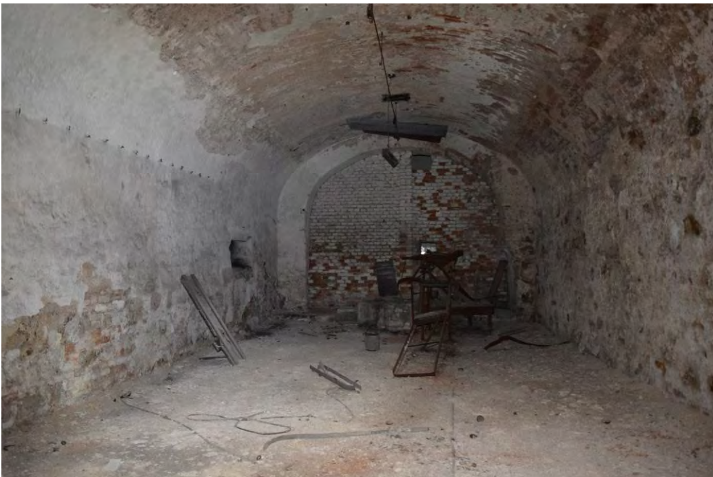
58, pohled do prostoru bývalých ležáckých sklepů směrem k jihu, k dodatečné cihelné zadržívce. Prostor 1.3.
