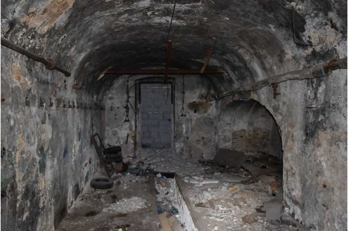
39 , pohled do prostoru 1.7 směrem k východní stěně. Vpravo je arkáda vstupu do sousedního prostoru 1.8 .
