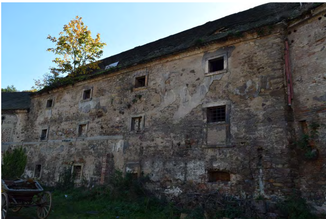
21 , detail severovýchodní fasády na části II sloužící jako sladovna. Všechna okna mají druhotný rozměr daný jejich snížením. Původní tvar oken včetně šambrány je dochovaný v pravé krajní ose uprostřed.
