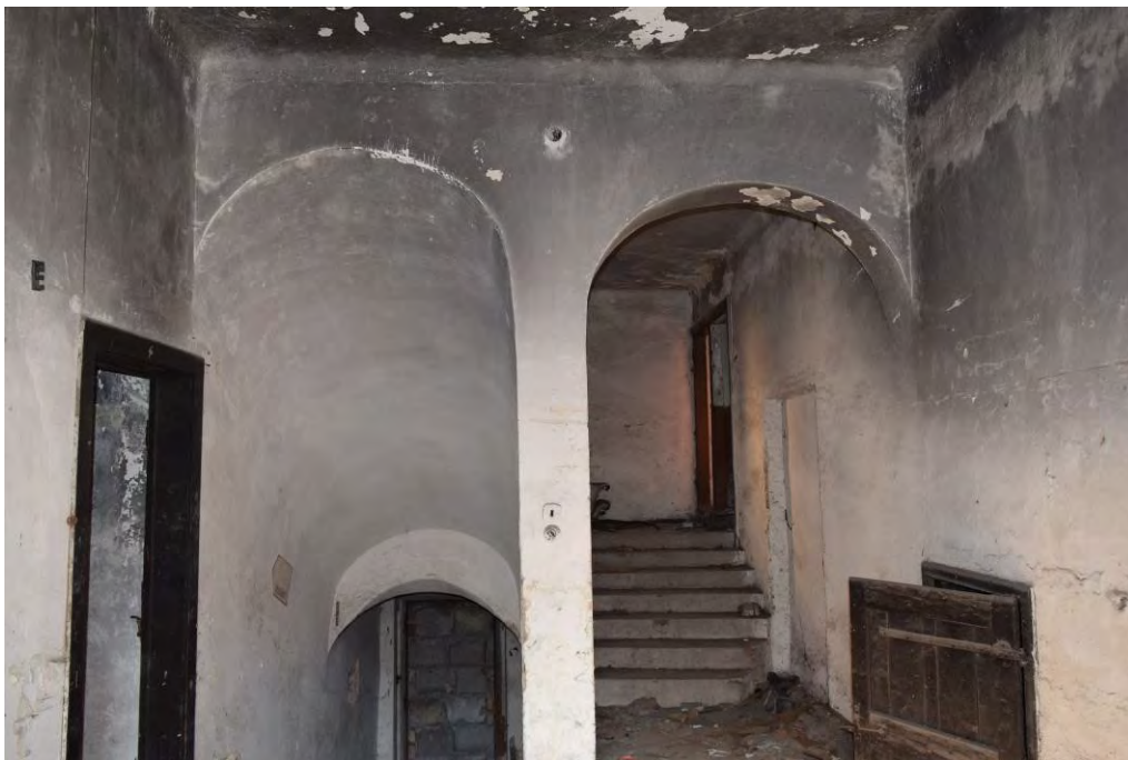
34, pohled na hlavní a jediné schodiště v čp. 1. Prostor 2.7.
