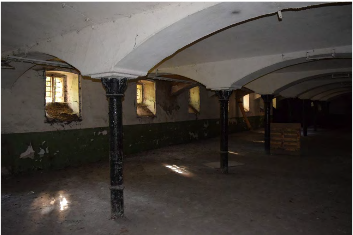
46, pohled do přízemí čp. 228 části III. Prostor je zaklenut řadou segmentových kleneb spočívajících na železných sloupech. Prostor 1.19.
