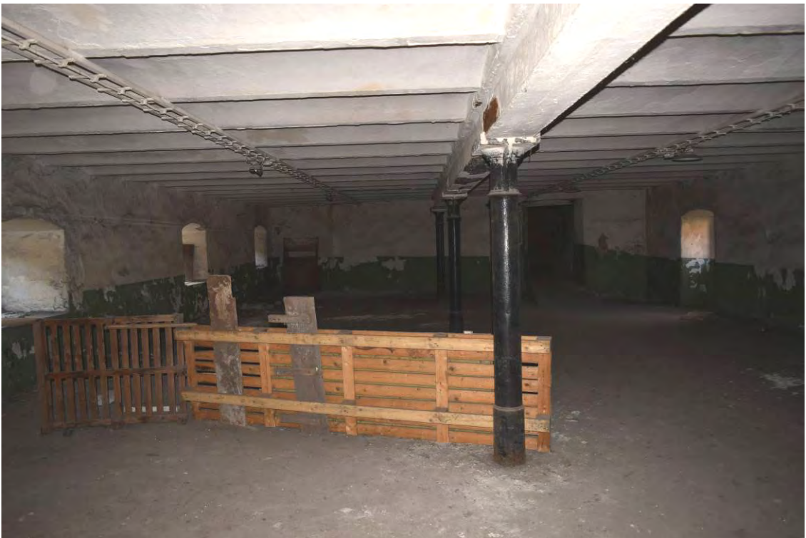
54, pohled do prostoru 2.9 , středový železný průvlak je podepřen železnými sloupy.
