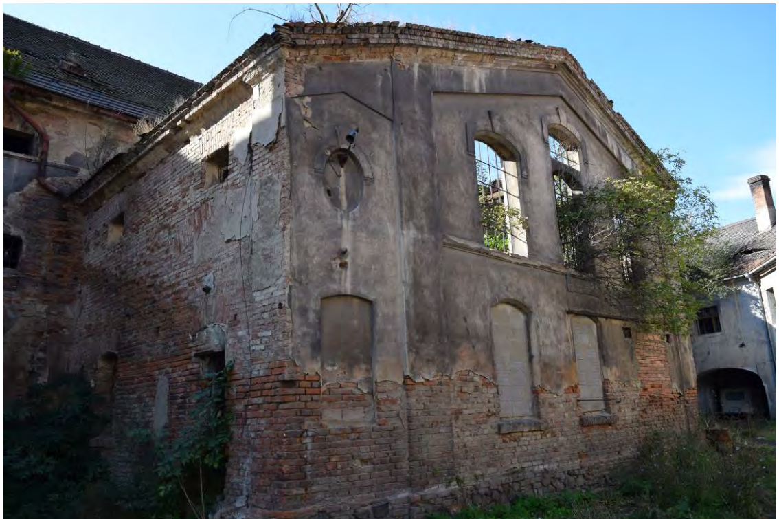
23, pohled na objekt bývalé kotelny se zbytky neoslohové fasády.
