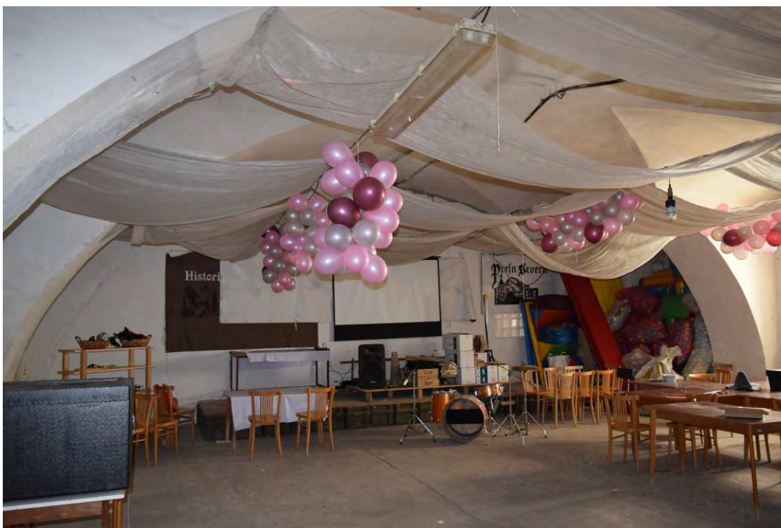
30, pohled na jižní stěnu velkého prostoru 1.19 . Pod výzdobou je opět valená klenba s pětibokými protilehlými nestyčnými výsečemi.
