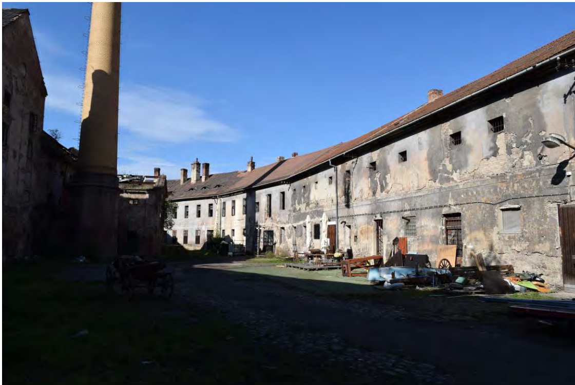
09, pohled na střední část dvorní fasády čp. 1.
