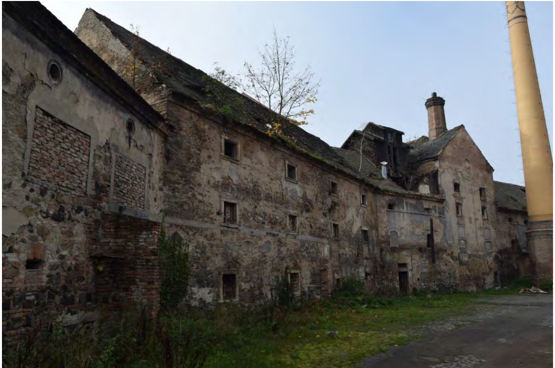
22, celkový pohled na severovýchodní fasádu směrem od jihovýchodu.
