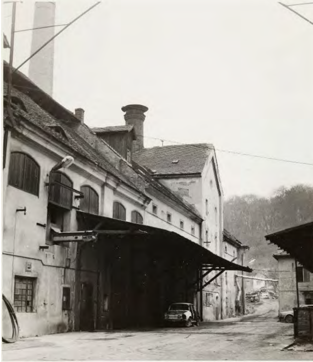
27, pohled na část západní fasády čp. 228, rok 1989. Fotoarchiv NPÚ.
