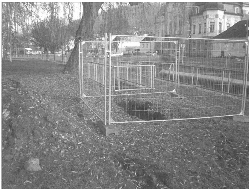
Kopaná sonda č. 1, po pravé straně chodník a koryto Bíliny s hladinou 4 m pod terénem
