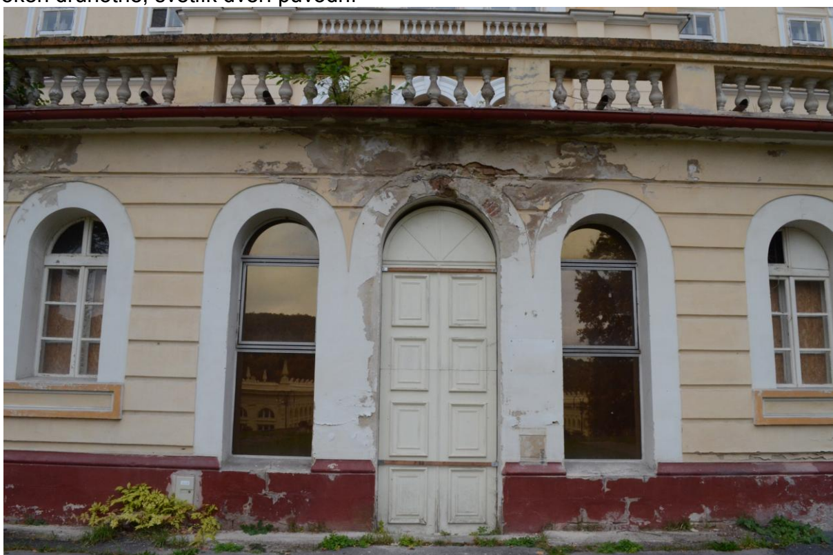
Obr. 4 Stěna měla původně plastické členění odpovídající předchozí fotografii, původní je sokl, výplně pod okny a fragmenty členění v napraží vstupu pod omítkami oprav
