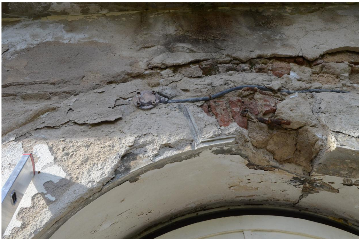
Obr. 5 Fragmenty členění v napraží vstupu pod omítkami oprav
