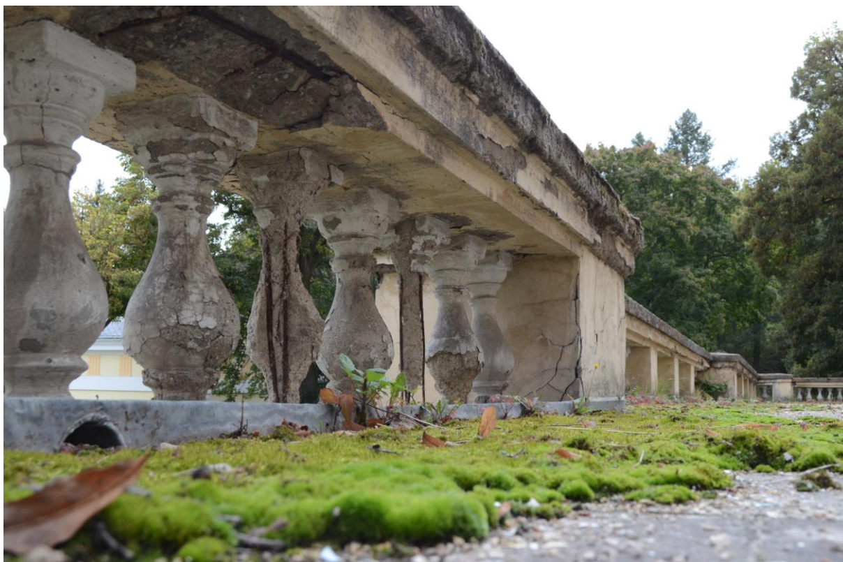
Obr. 7 Balustráda terasy je místy v havarijním stavu (koroze kovové armatury)
