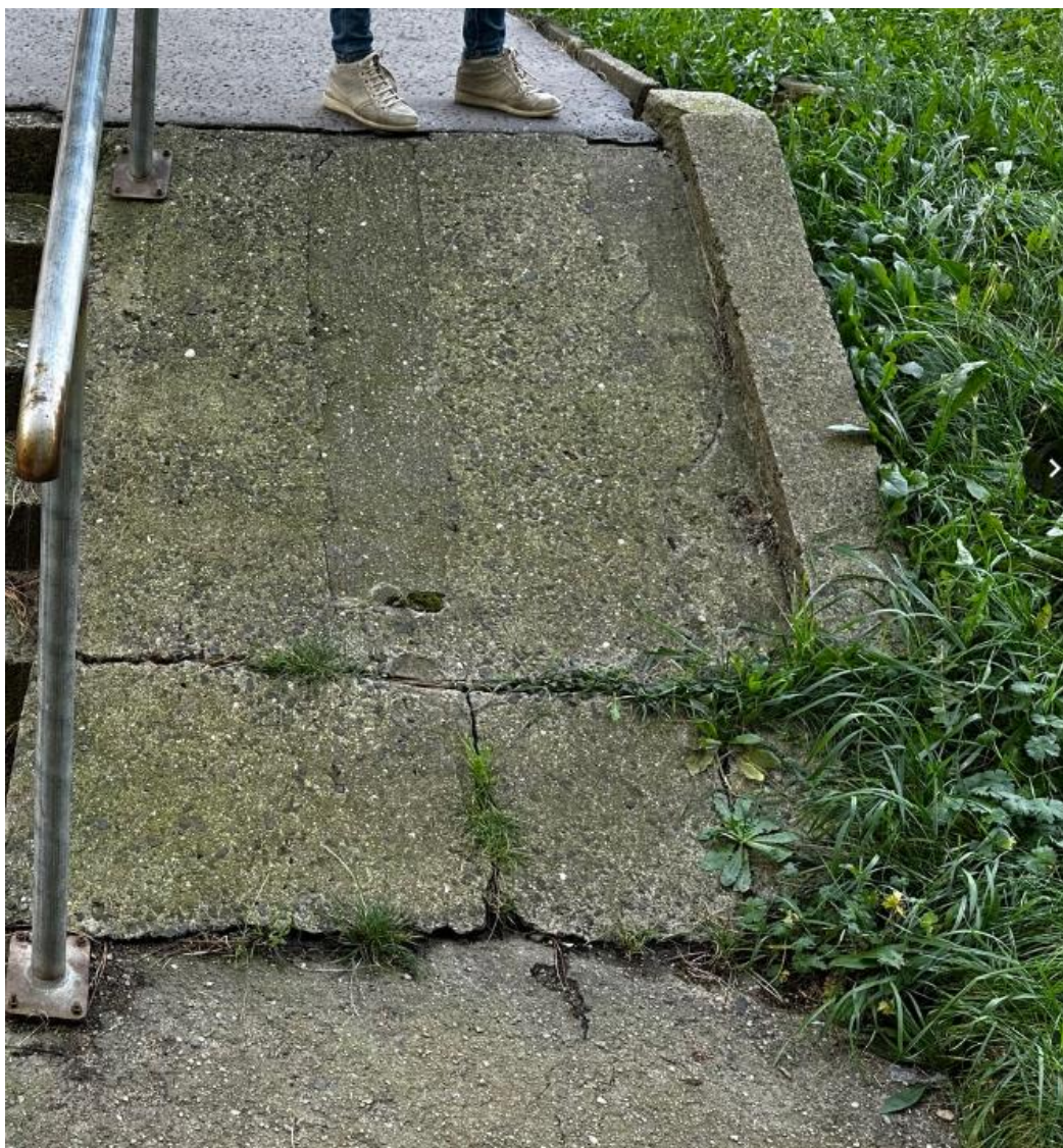
Stávající rampa neodpovídá ČSN 73 4130 a je navržena její demolice.
