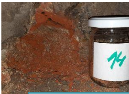
Obvodové zdivo - vlhkost a salinita
