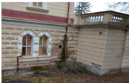
Degradace zdiva JZ strany - 1. PP
