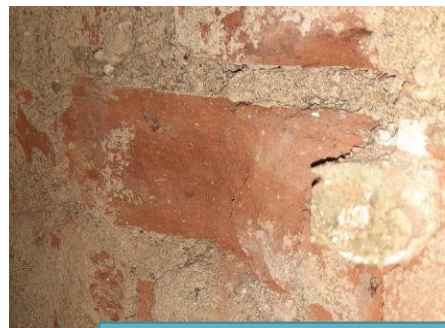
Degradace zdiva v 1.NP
