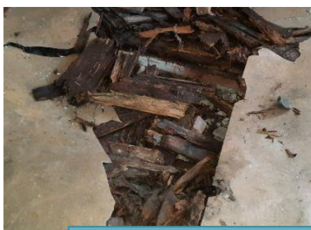
Působení vlhkosti na dřevěné podlahy v 1.NP
