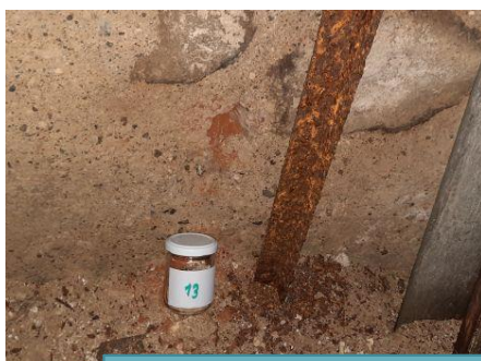
Degradované omítky a zdivo vlivem vlhkosti a salinity
